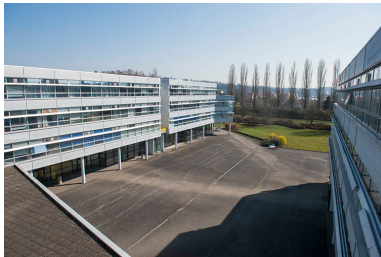
Cour vue de l'externat. Phot. Mary Ruffinoni IVR43_20149000122NUC4A
