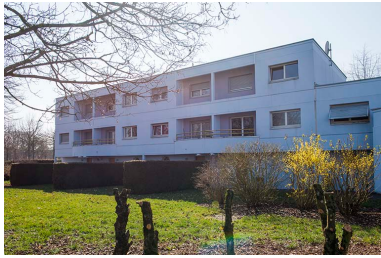
Façade postérieure est des logements sud-ouest.
