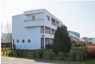
Pignon est des logements nord-est. Phot. Mary Ruffinoni IVR43_20149000130NUC4A
