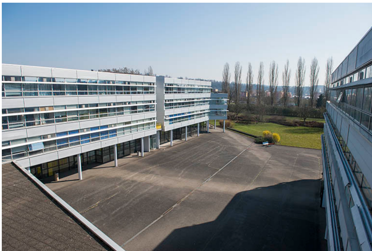
Cour vue de l'externat.
