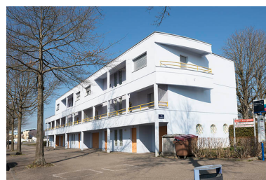
Angle sud-ouest des logements sud-ouest.
