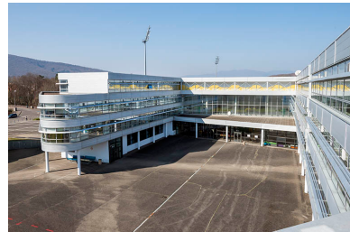
Cour vue du sud. Phot. Mary Ruffinoni IVR43_20149000123NUC4A
