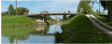
Vue du pont depuis l'aval. Phot. Pierre-Marie Barbe-Richaud IVR26_20112103871NUC4AQ
