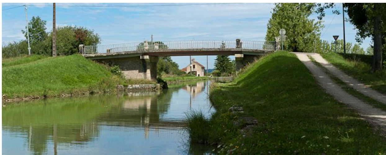
Vue du pont depuis l'aval.
