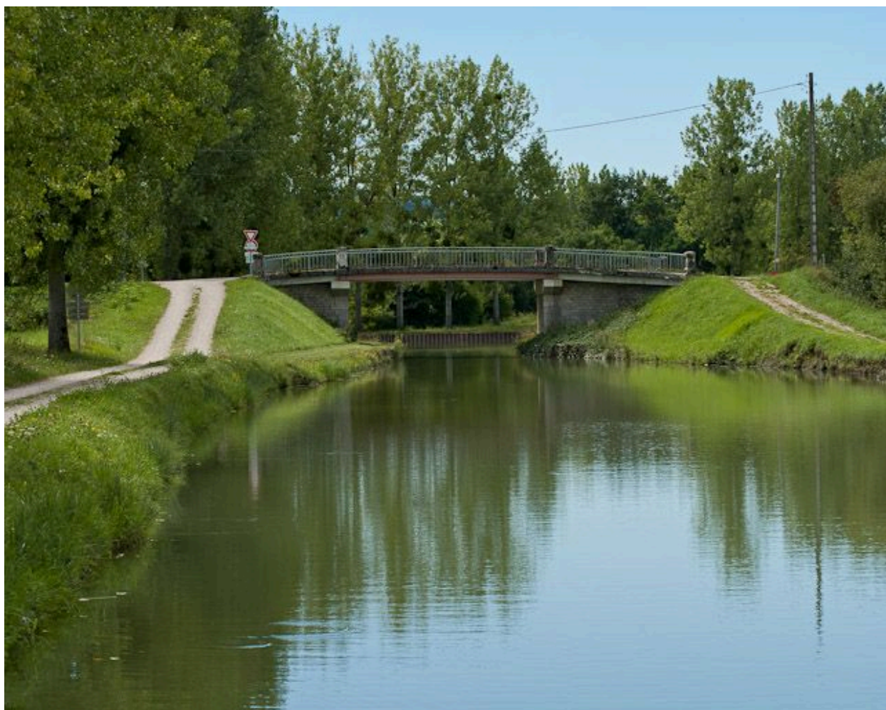
Vue du pont depuis l'amont.
