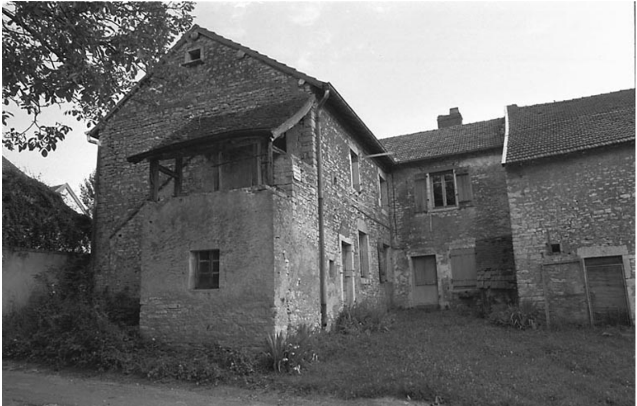
Partie gauche : habitation avec escalier extérieur.
