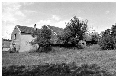
Façade postérieure de la partie droite. Phot. Bernard Lardière IVR43_19817000623Z
