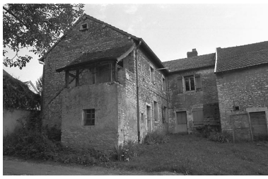
Partie gauche : habitation avec escalier extérieur. Phot. Bernard Lardière IVR43_19817000620Z
