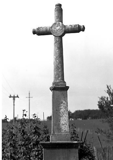
Croix de chemin située Grande Rue. Phot. Yves Sancey IVR43_19802500851X
