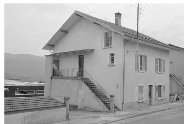
Magasin industriel (ancien logement) à l'entrée de l'usine. Phot. Laurent Poupard IVR43_19913901006Z
