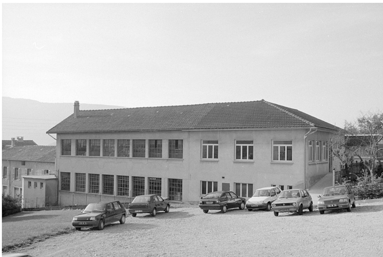
Atelier de fabrication (H), vu du nord-ouest.
