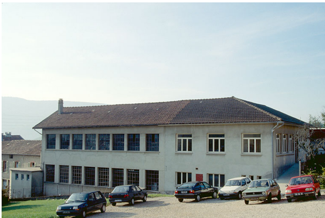
Atelier de fabrication (H), vu du nord-ouest.
