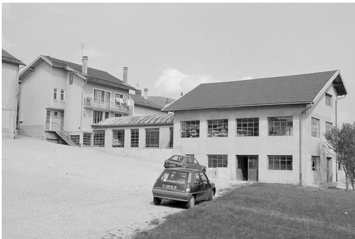
Ancienne tournerie Forestier, vue du sud-est.
