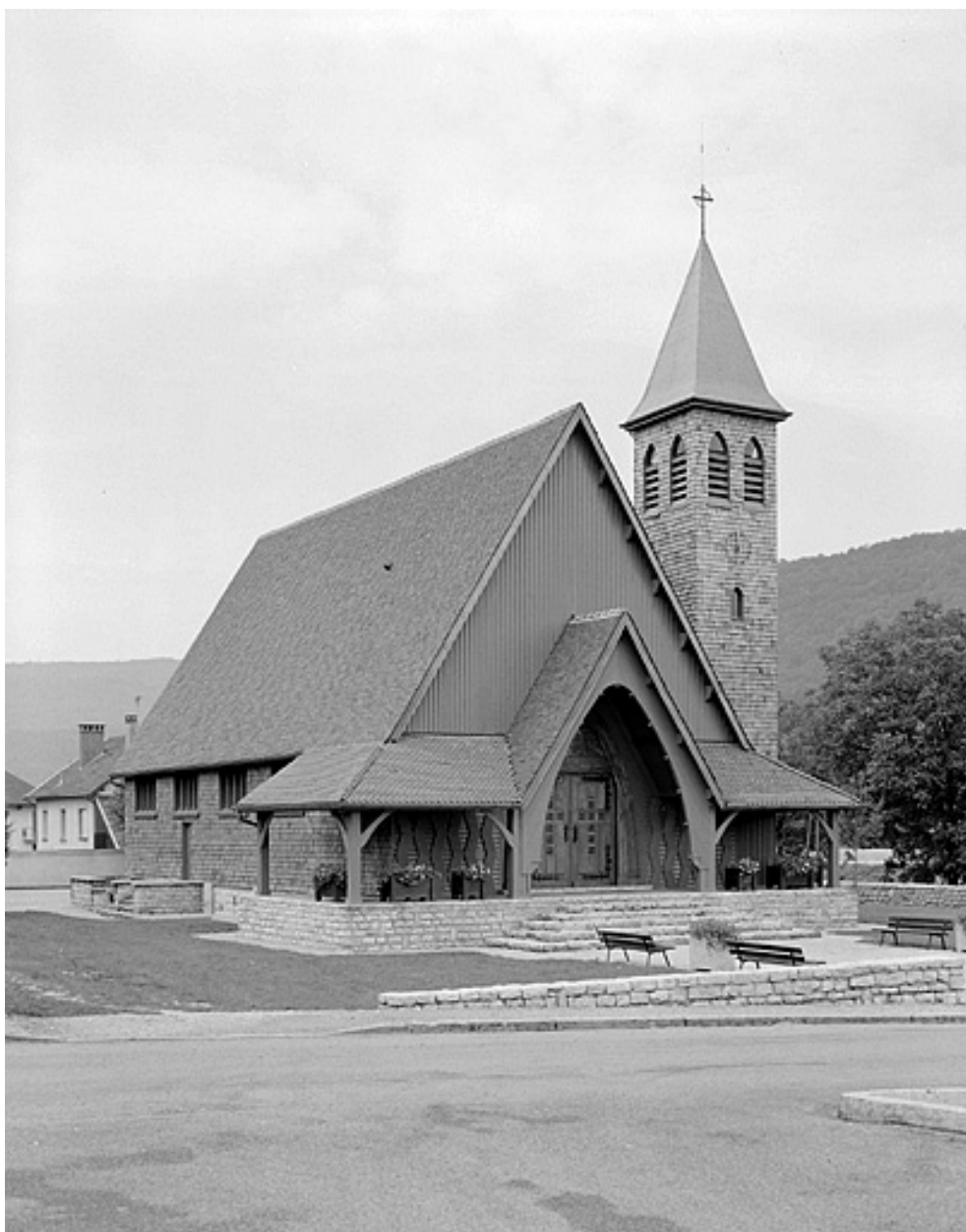
Façade ouest et face nord.
