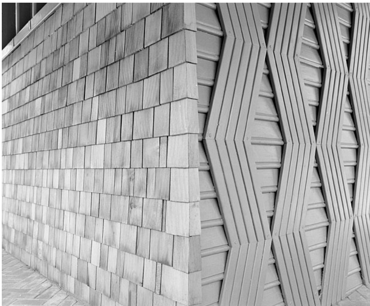
Détail du revêtement extérieur à l'angle de la façade ouest et de la face nord.
