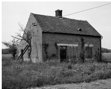
Logis d'une ferme (cad. 1934, sect. A2, parc. 124). Phot. Michel Rosso IVR26_19862100504X
