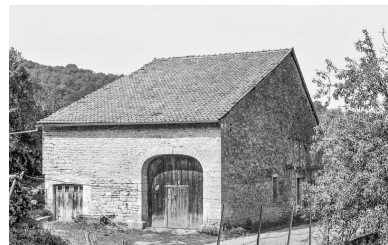
Façade latérale gauche. Phot. Bernard Pontefract IVR43_19763900332Z
