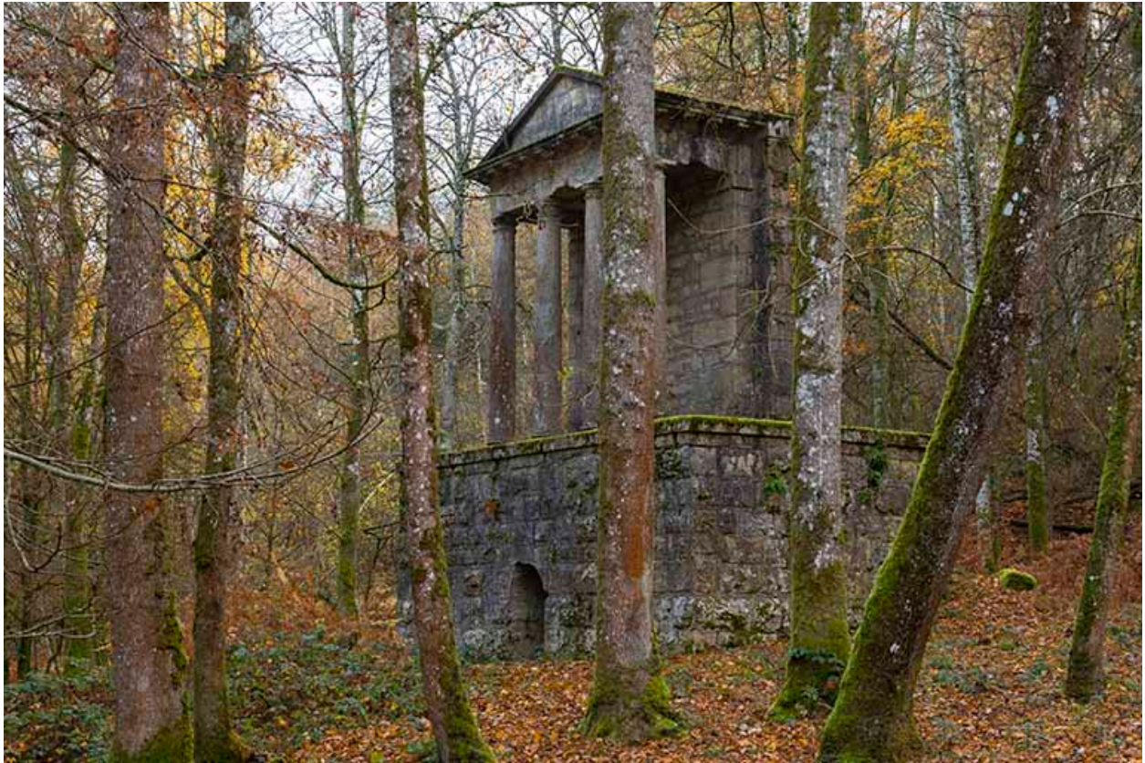
Vue d'ensemble, dans le parc du château.
