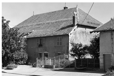
Maison située 1 route de la Barèche.
