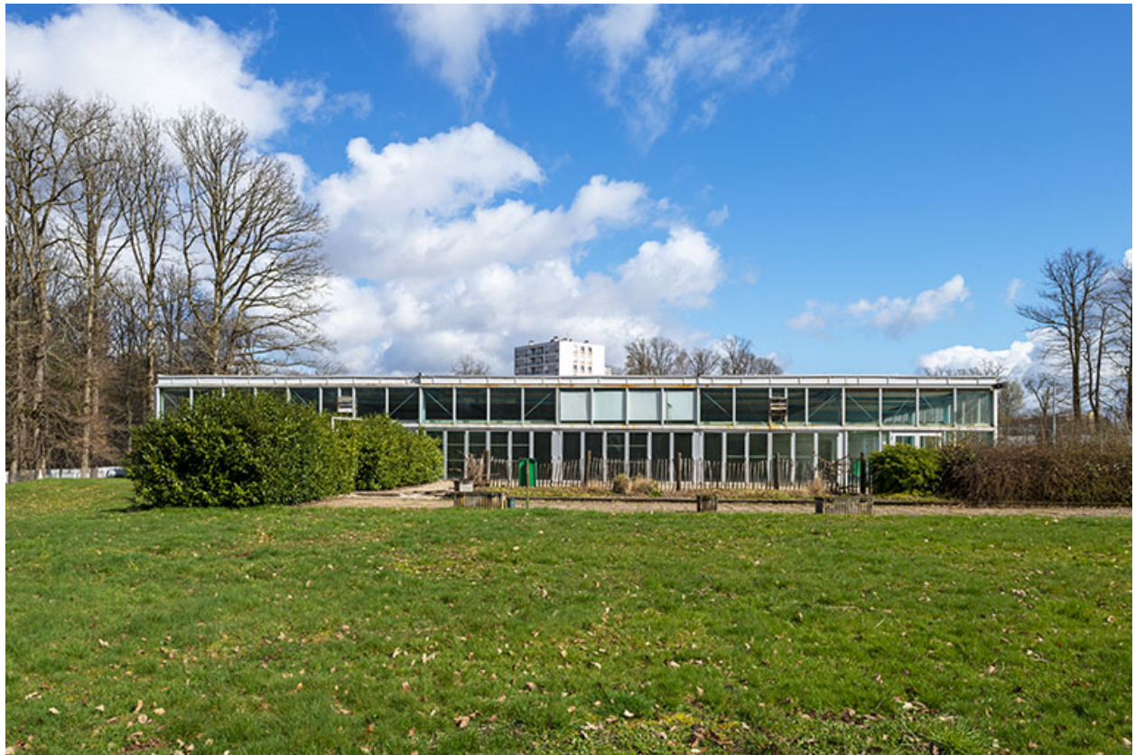
La façade sud-ouest.
