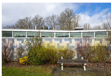
Détail de la façade sud- est, partie de l'annexe. Phot. Aline Thomas IVR43_20267000047NUC4A
