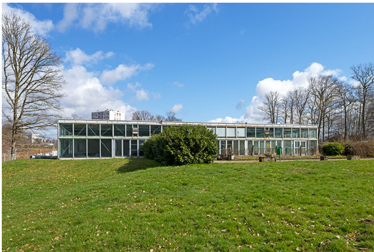
La façade sud-ouest.
