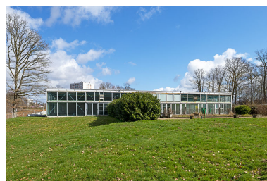
La façade sud-ouest. Phot. Aline Thomas IVR43_20267000056NUC4A
