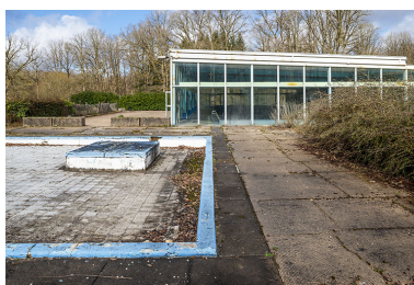
La pataugeoire et la piscine. Phot. Aline Thomas IVR43_20267000050NUC4A
