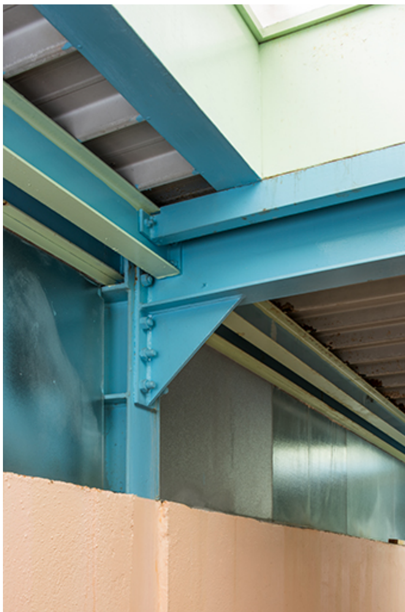
Détail du système poteau-poutre du vestiaire.
