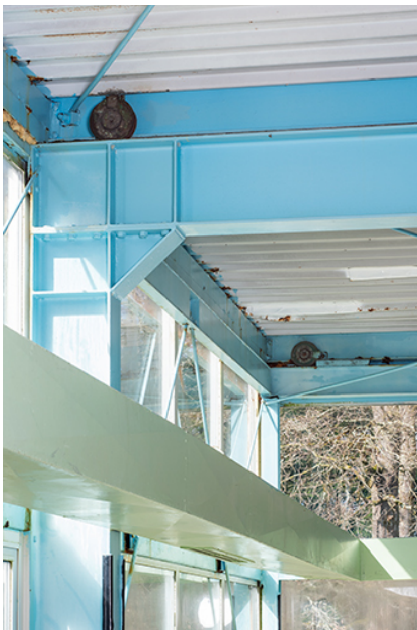
Gaine d'aération et système poteau-poutre couvrant le bassin.
