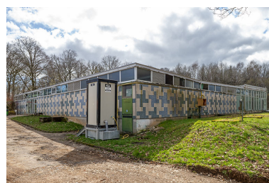
L'angle nord (façades nord-ouest et nord-est). Phot. Aline Thomas IVR43_20267000062NUC4A
