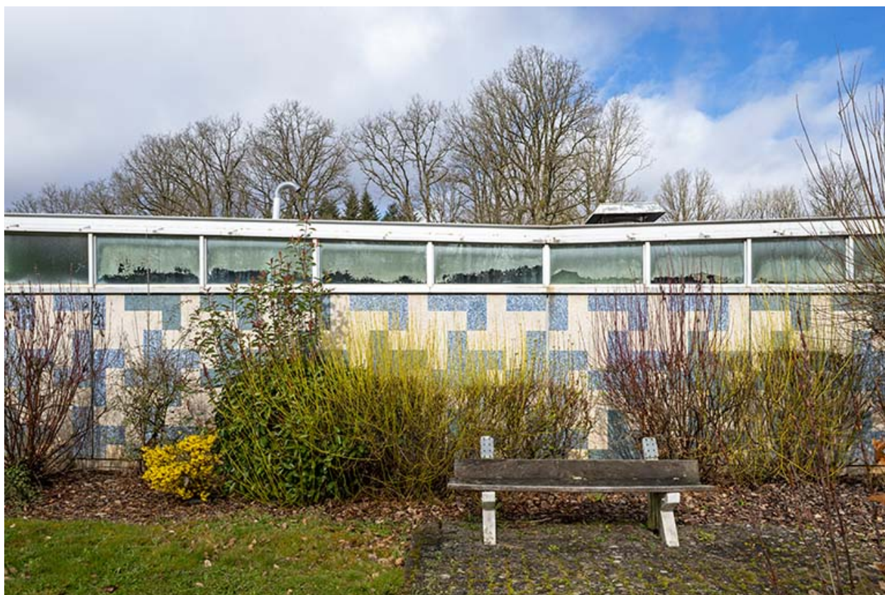
Détail de la façade sud-est, partie de l'annexe.
