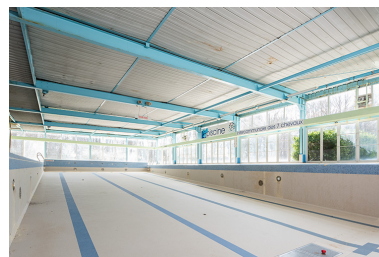
Le fond du bassin de la piscine, depuis l'angle nord-est. Phot. Nicolas Waltefaugle IVR43_20267000016NUC4A
