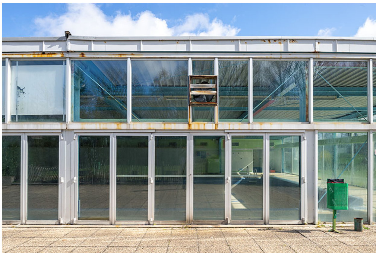
Détail de la façade sud-ouest.
