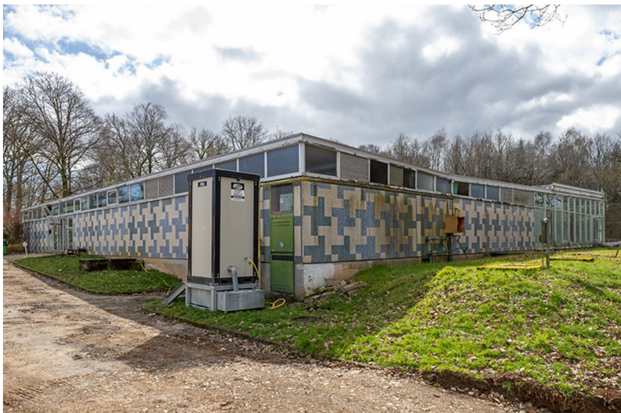
L'angle nord (façades nord-ouest et nord-est).
