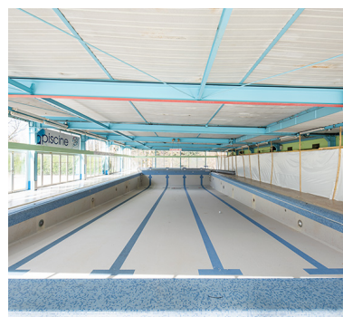
L'ensemble du bassin de la piscine, depuis le sud-est. Phot. Nicolas Waltefaugle IVR43_20267000010NUC4A
