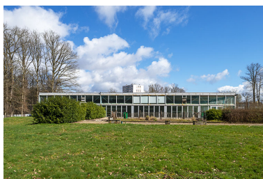
La façade sud-ouest. Phot. Aline Thomas IVR43_20267000055NUC4A
