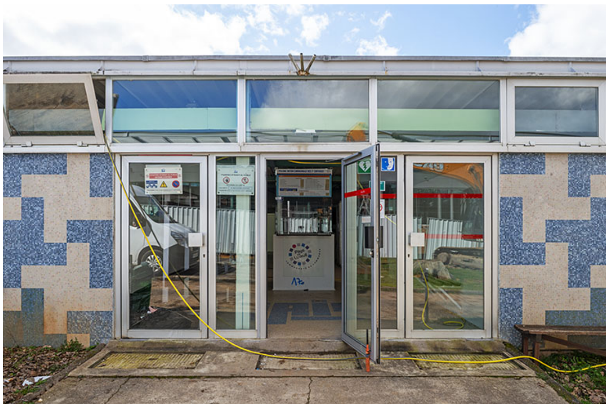
L'entrée de la piscine sur la façade nord-est.
