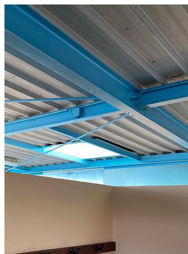
Les poutres métalliques dans les vestiaires.
