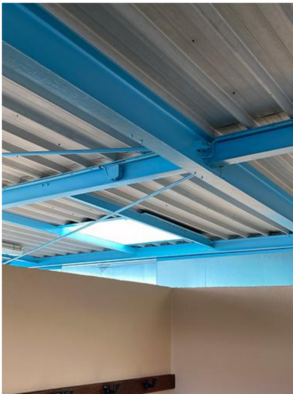
Les poutres métalliques dans les vestiaires.
