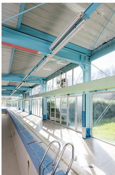
L'élévation sud-ouest de l'intérieur de la piscine, depuis le nord. Phot. Nicolas Waltefaugle IVR43_20267000014NUC4A
