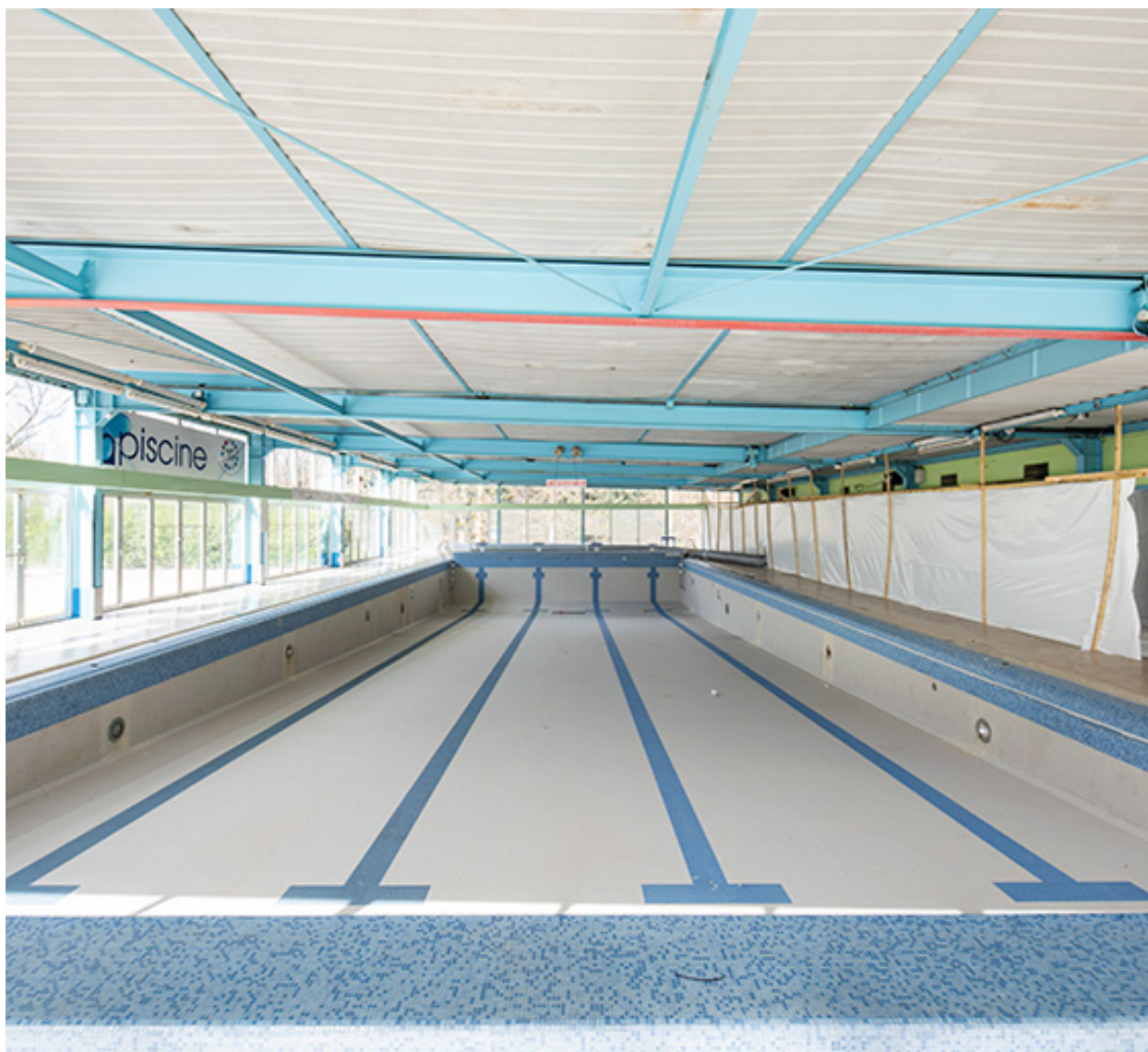
L'ensemble du bassin de la piscine, depuis le sud-est.
