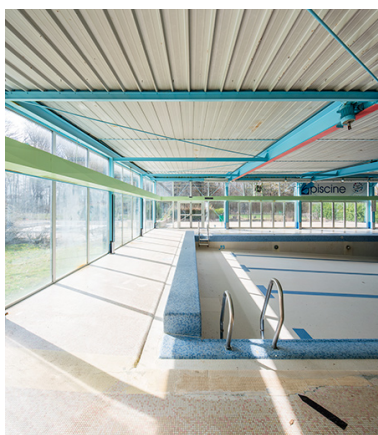
L'entrée du bassin depuis les vestiaires des filles. Phot. Nicolas Waltefaugle IVR43_20267000011NUC4A
