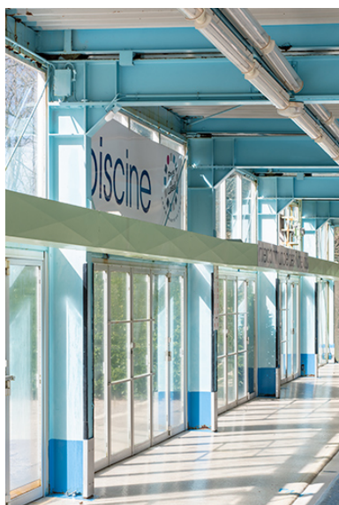
L'élévation sud-ouest de l'intérieur de la piscine, depuis le sud. Phot. Nicolas Waltefaugle IVR43_20267000019NUC4A
