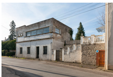
Les bureaux. Phot. Jérôme Mongreville IVR43_20152501015NUC4A
