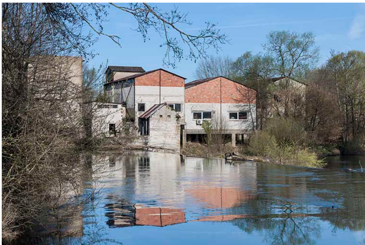
Vue d'ensemble depuis l'amont du barrage.
