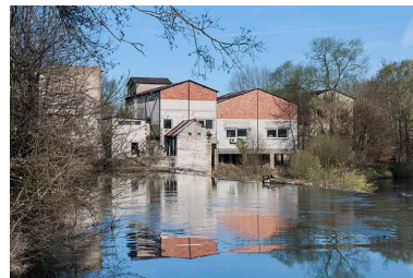
Vue d'ensemble depuis l'amont du barrage. Phot. Jérôme Mongreville IVR43_20152501017NUC4A
