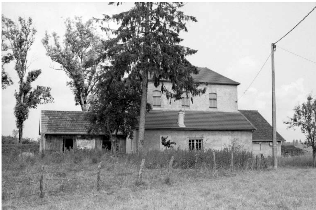
Atelier de fabrication (A).
