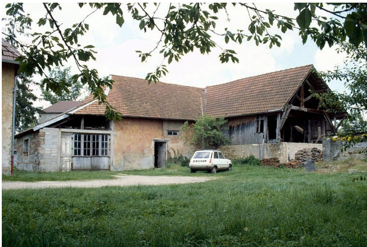
Atelier de fabrication (B), depuis le sud-est.
