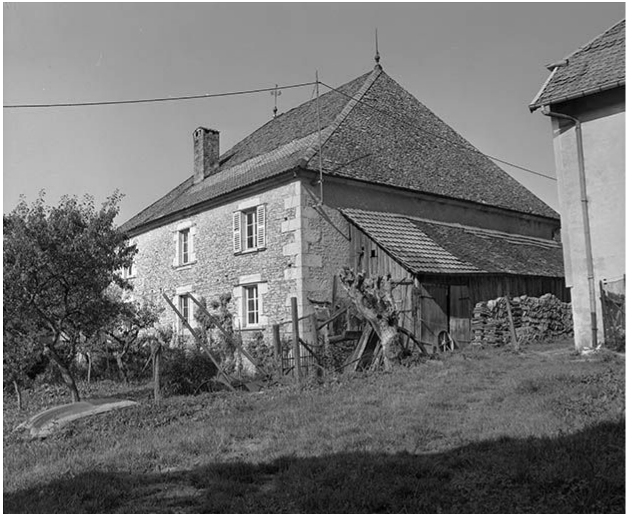
Façade postérieure vue de trois quarts droit.
