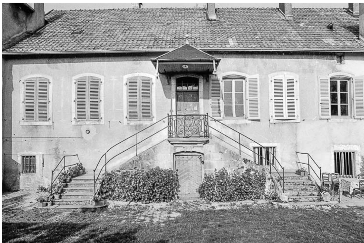
Façade antérieure et escalier à double volée.
