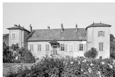
Façade antérieure et jardin. Phot. Bernard Pontefract IVR43_19763900384Z
