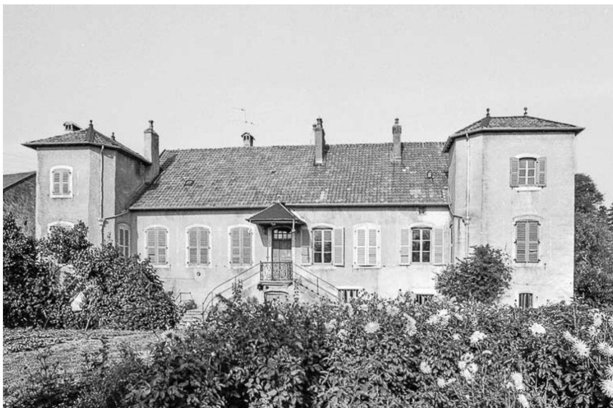
Façade antérieure et jardin.
