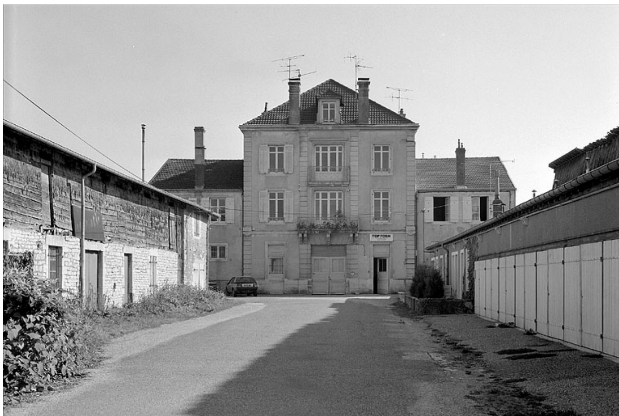
Vue d'ensemble de l'habitation, de face.
