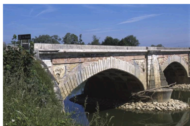
Détail d'une arche. Phot. Jean-Luc Duthu IVR26_20017100195ZA
