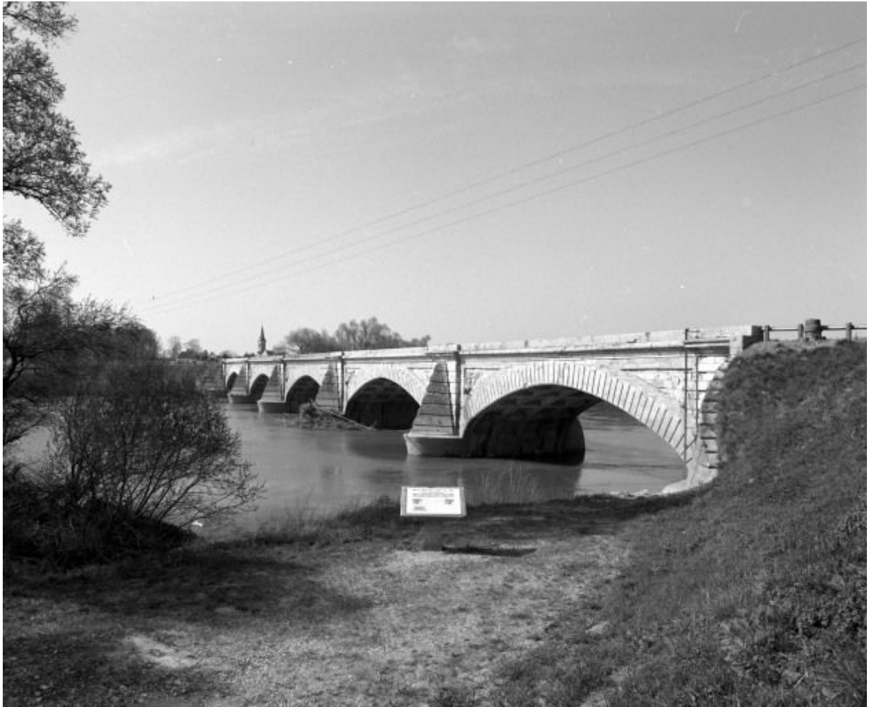
Vue d'ensemble en amont.
