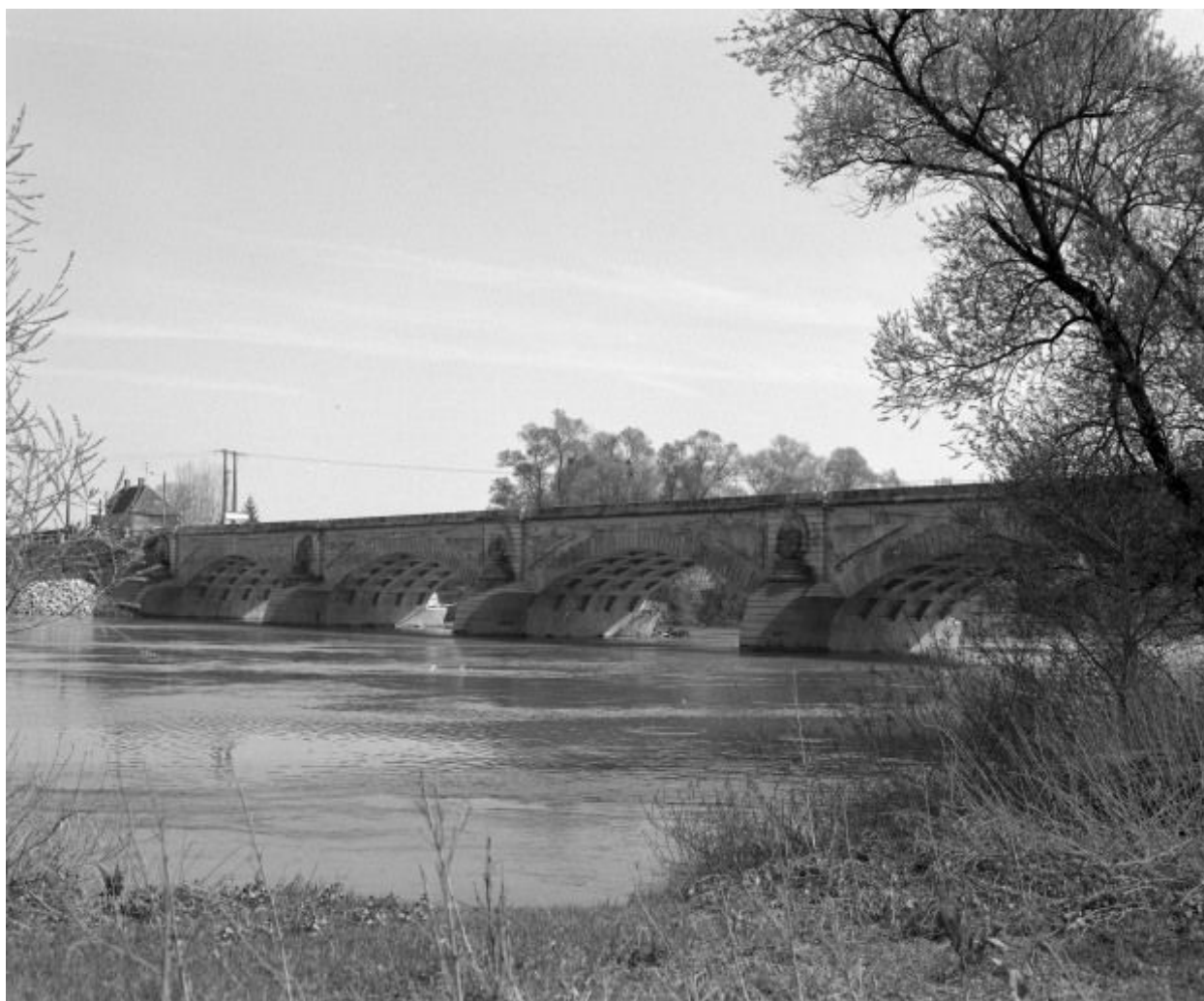
Vue d'ensemble de trois-quarts droit, en aval.
