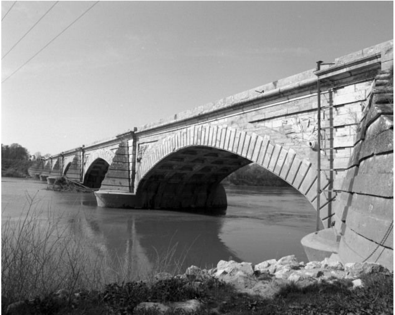
Vue d'ensemble rapprochée, en amont.
