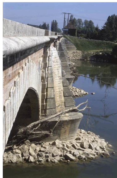
Détail d'une pile. Phot. Jean-Luc Duthu IVR26_20017100194ZA
