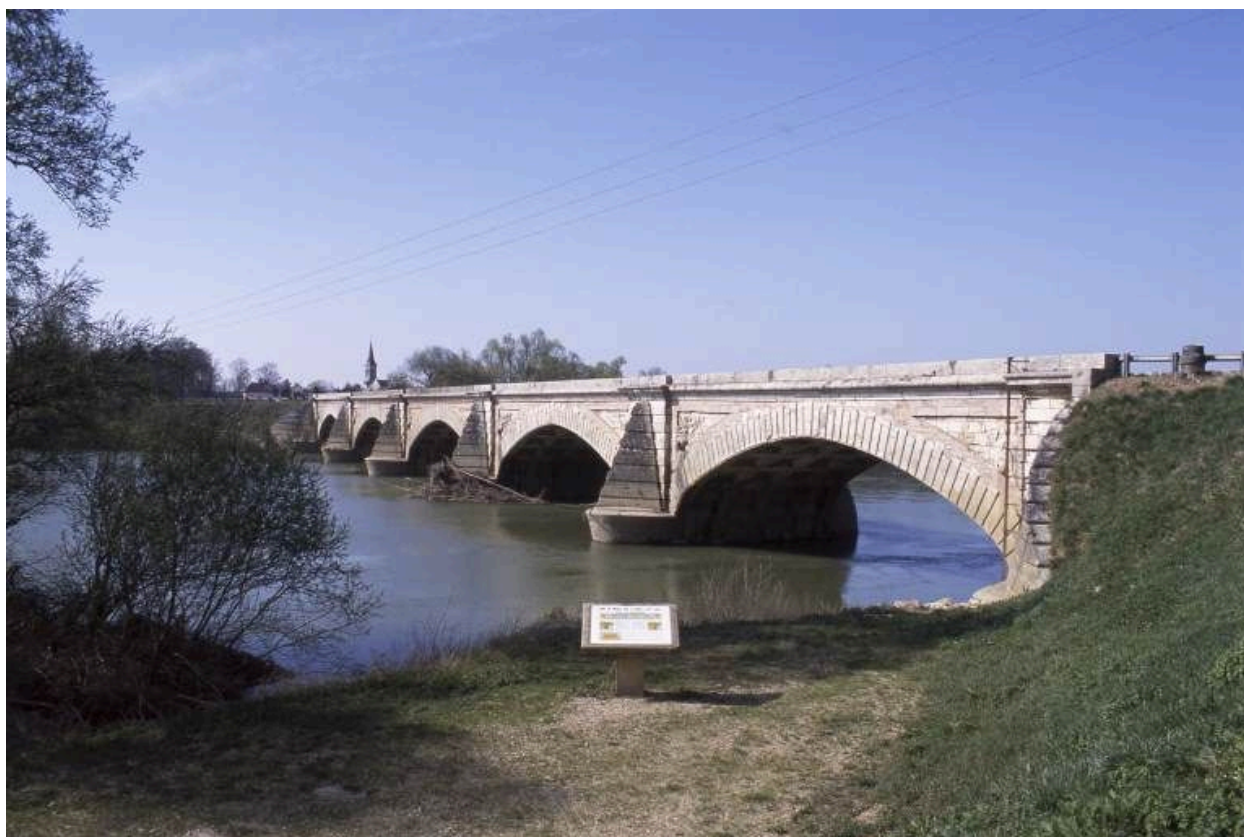
Vue d'ensemble en amont.
