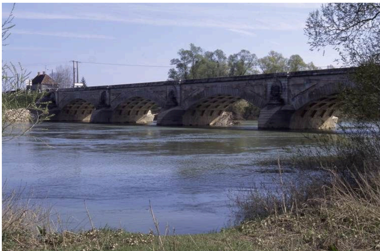
Vue d'ensemble de trois-quarts droit, en aval.
