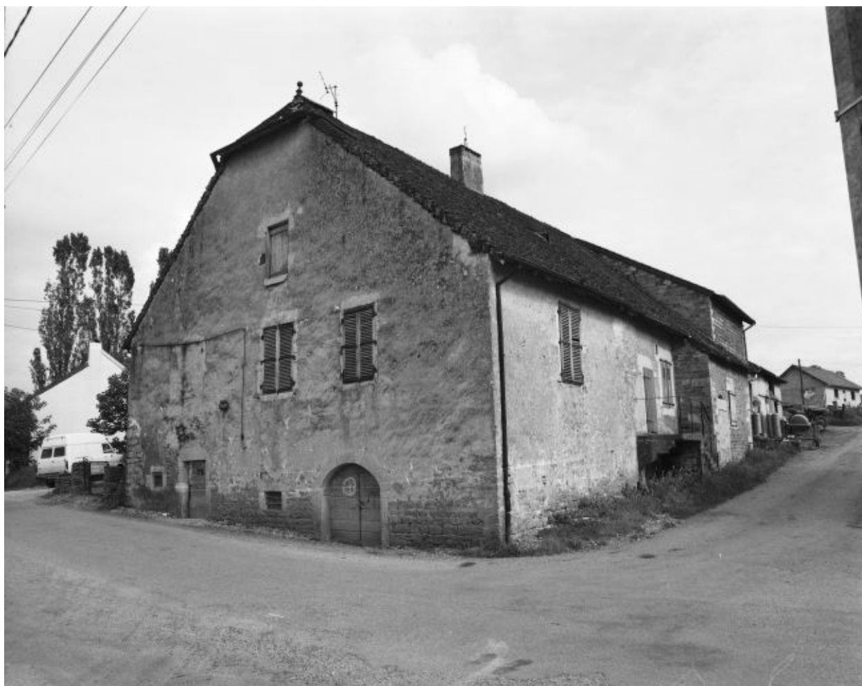
Ferme située rue des Louvarets.
