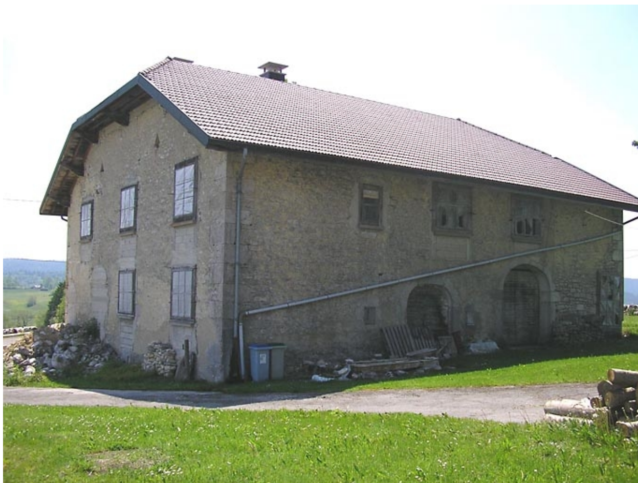
Pignon nord-est vu de trois quarts.
