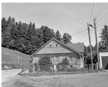
Ferme située au lieu-dit Le Chauffaud : façade latérale droite. Phot. Dominique Humbert IVR43_19762500451X
