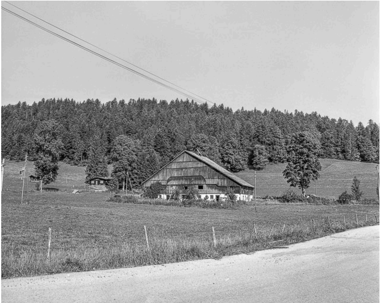
Ferme située au lieu-dit Le Chauffaud : vue d'ensemble.
