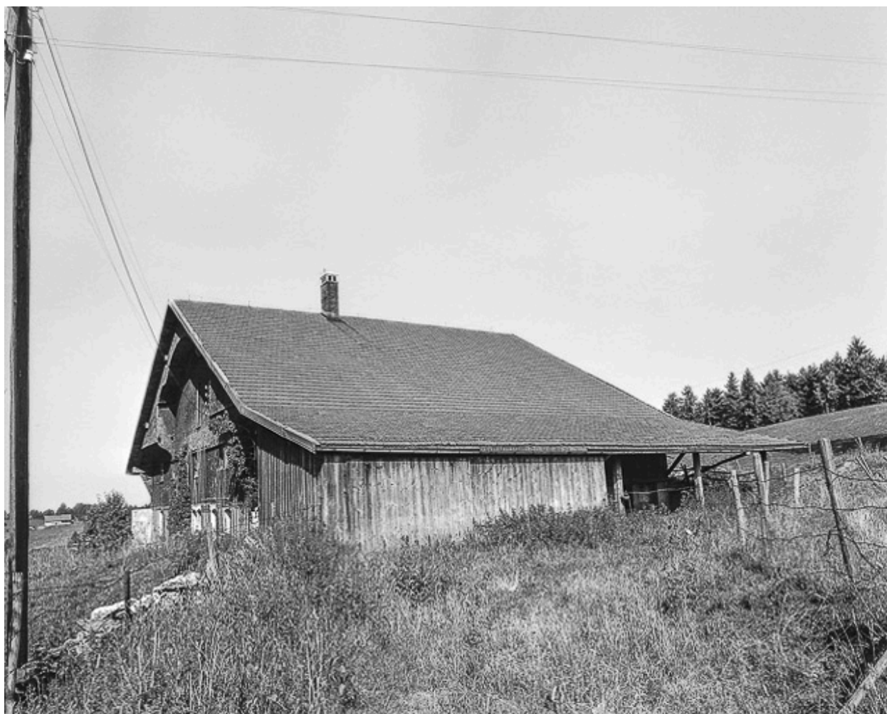
Ferme située au lieu-dit Sur la Roche : façade latérale droite.
