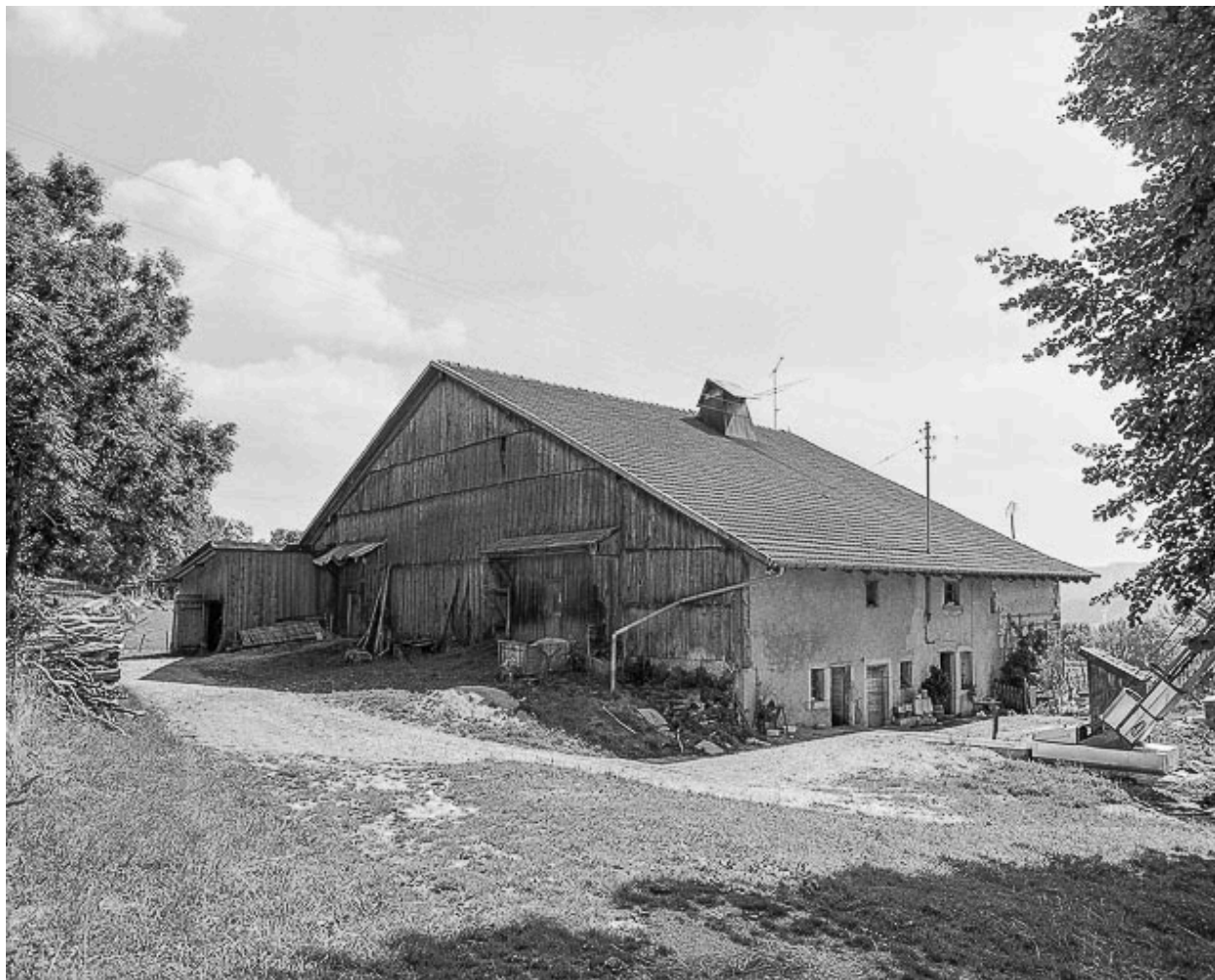
Ferme située au lieu-dit Pré Noë : façades postérieure et latérale gauche.
