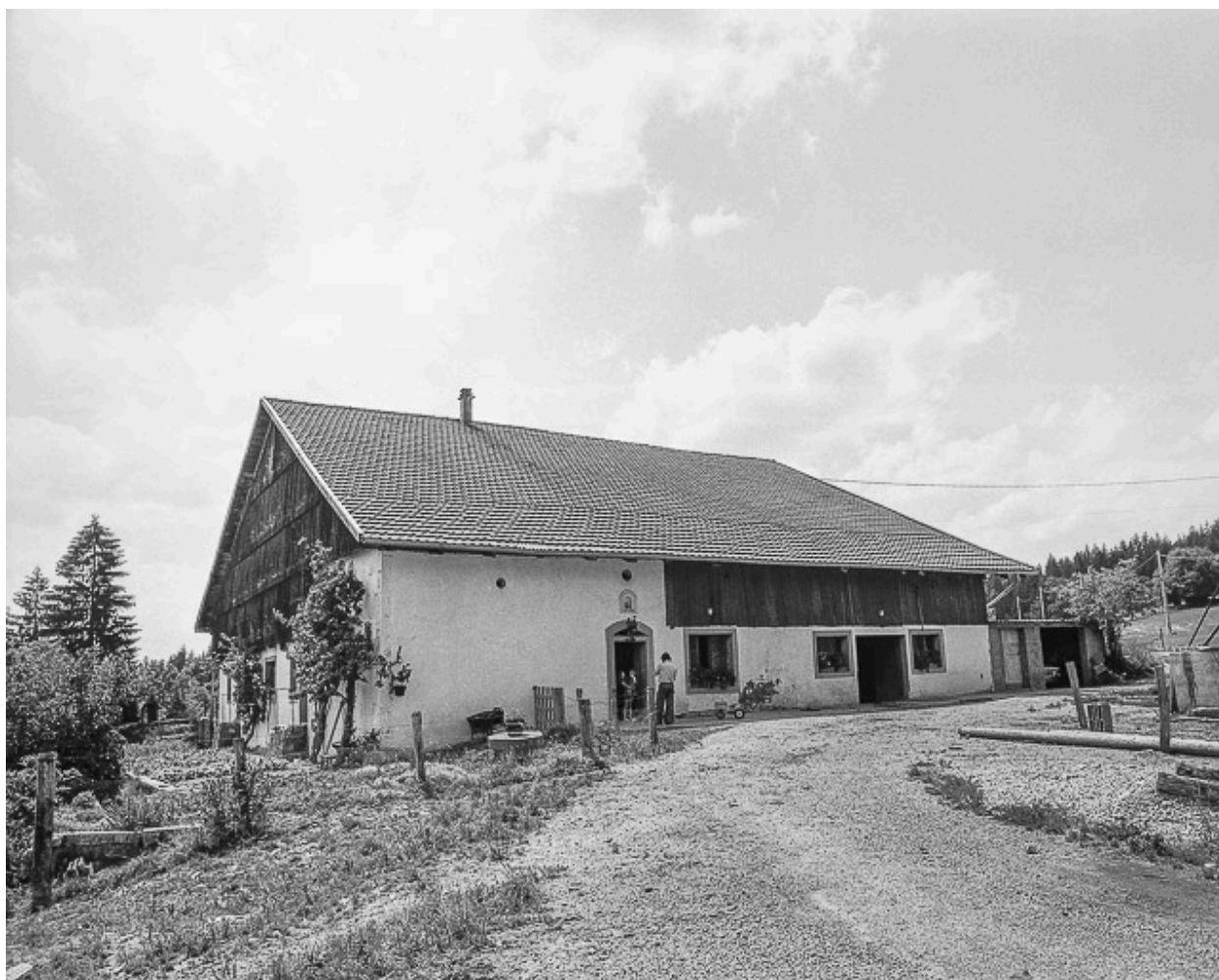
Ferme située au lieu-dit Cerneux Billard, cadastrée A2 : façade antérieure et latérale gauche.
