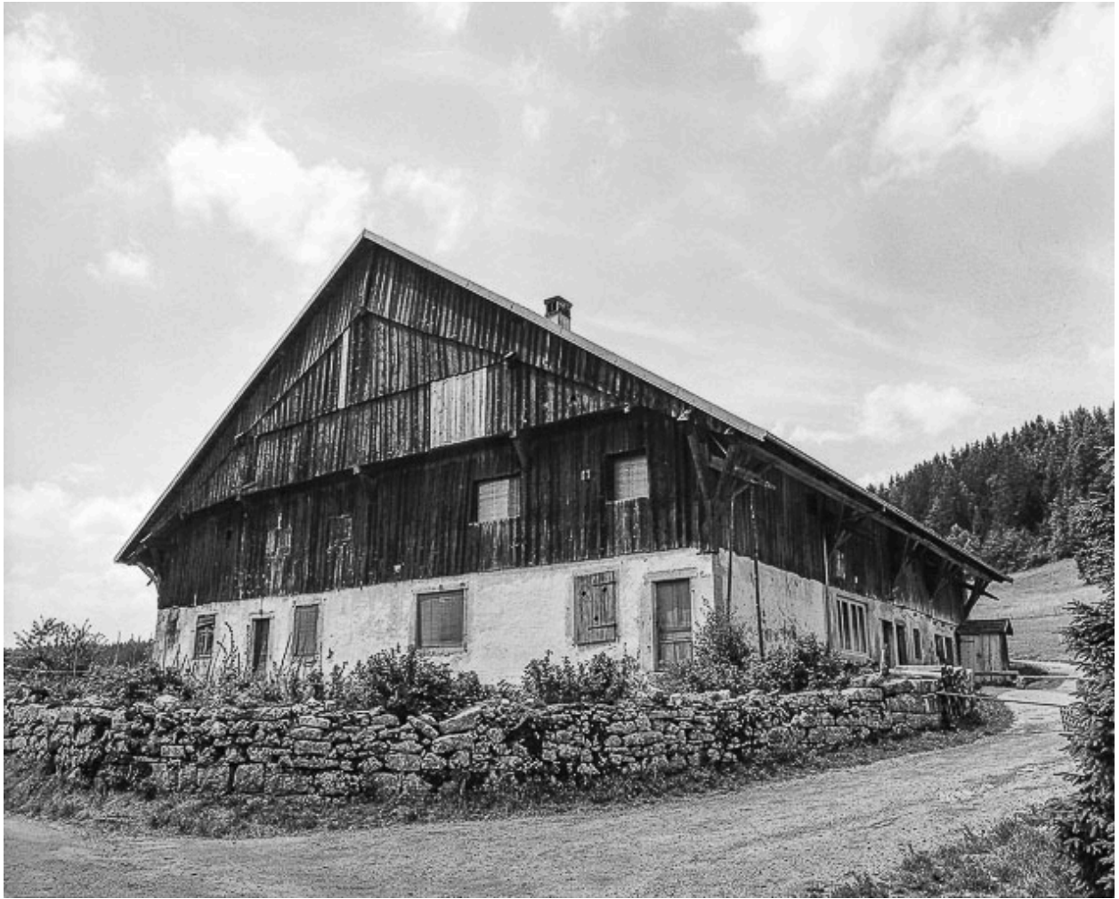
Ferme située au lieu-dit Pré du Nord : façade antérieure et latérale gauche.
