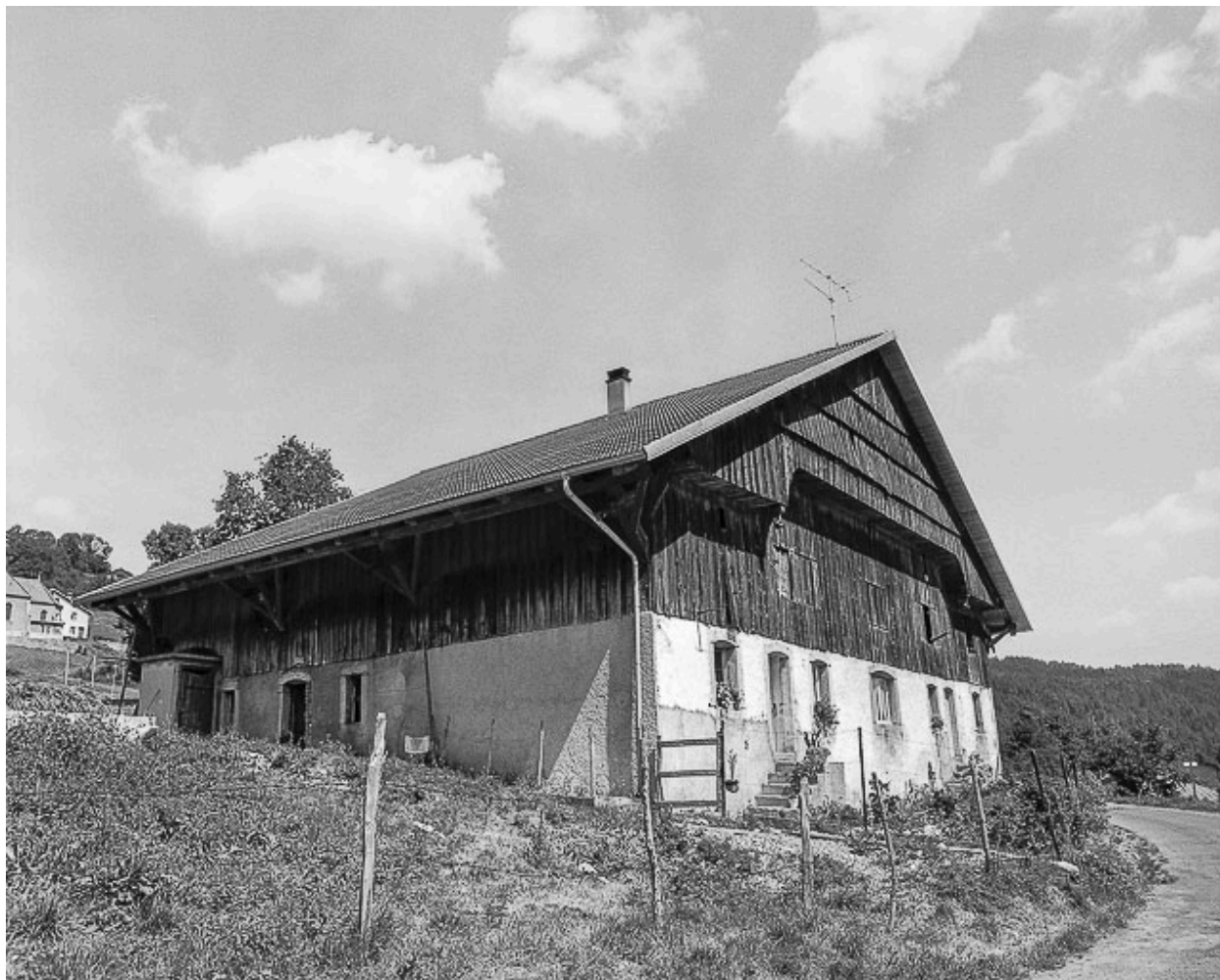
Ferme située au lieu-dit Le Pissoux : façades antérieure et latérale gauche.
