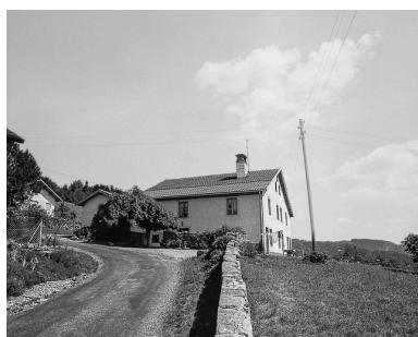
Ferme située au lieu-dit Le Pissoux : vue d'ensemble. Phot. Dominique Humbert IVR43_19762500429X
