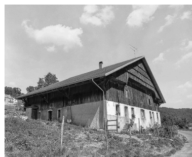
Ferme située au lieu-dit Le Pissoux : façades antérieure et latérale gauche. Phot. Dominique Humbert IVR43_19762500431X
