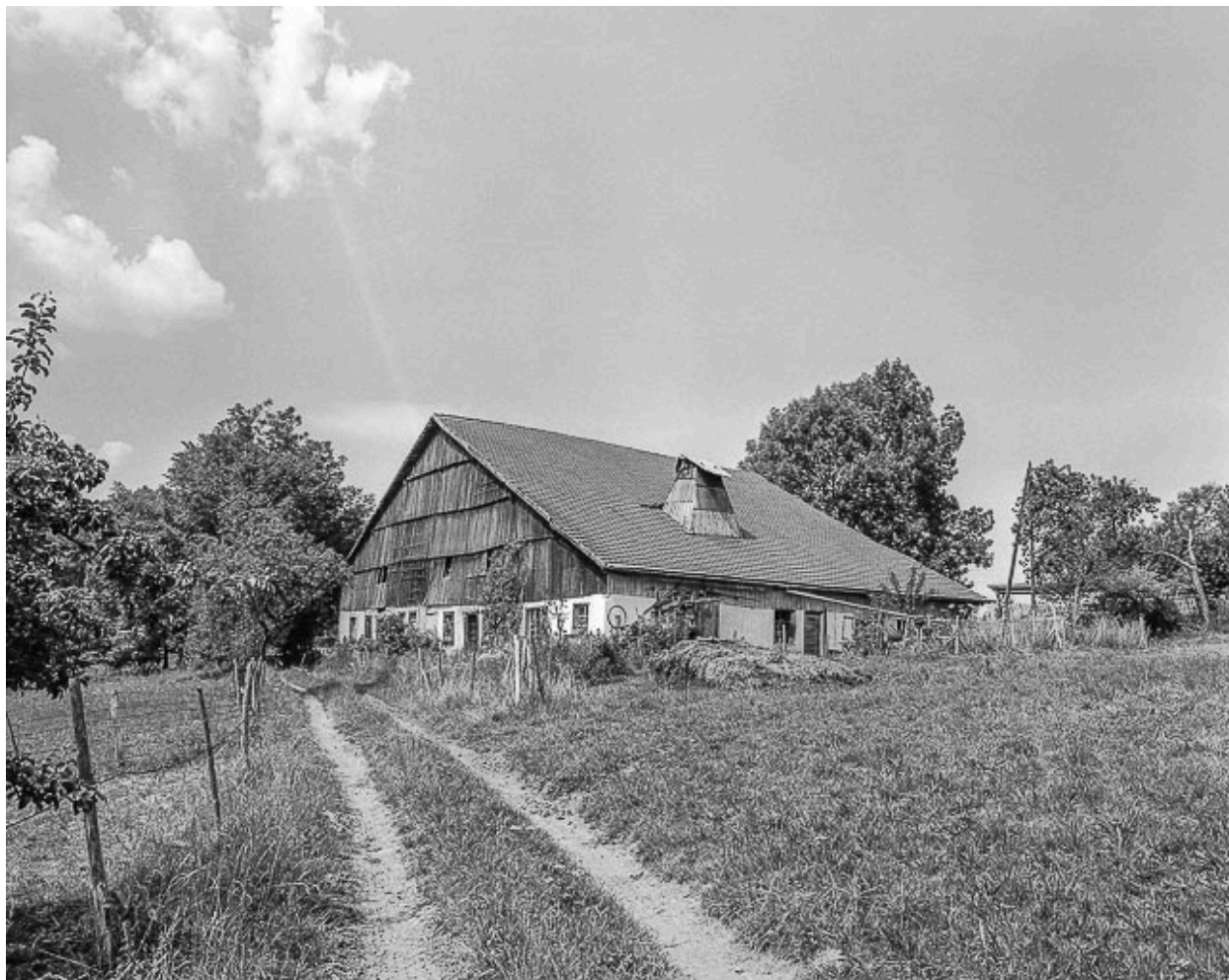
Ferme située au lieu-dit Le Prélot : façades antérieure et latérale droite.
