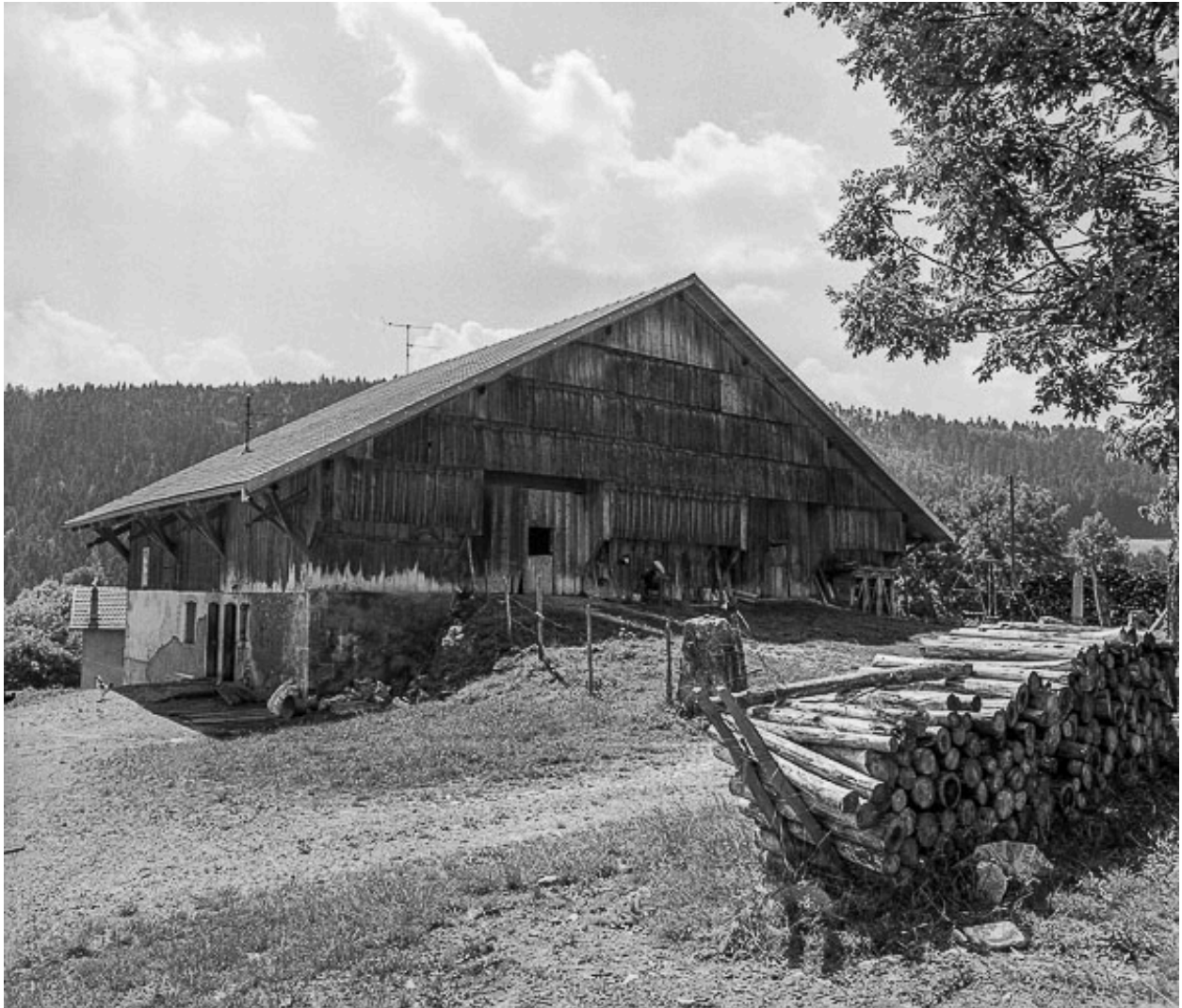
Ferme située au lieu-dit Le Pissoux : façade postérieure.
