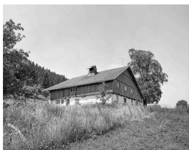
Ferme située au lieu-dit Ronde Sommette : façades antérieure et latérale gauche. Phot. Dominique Humbert IVR43_19762500452X
