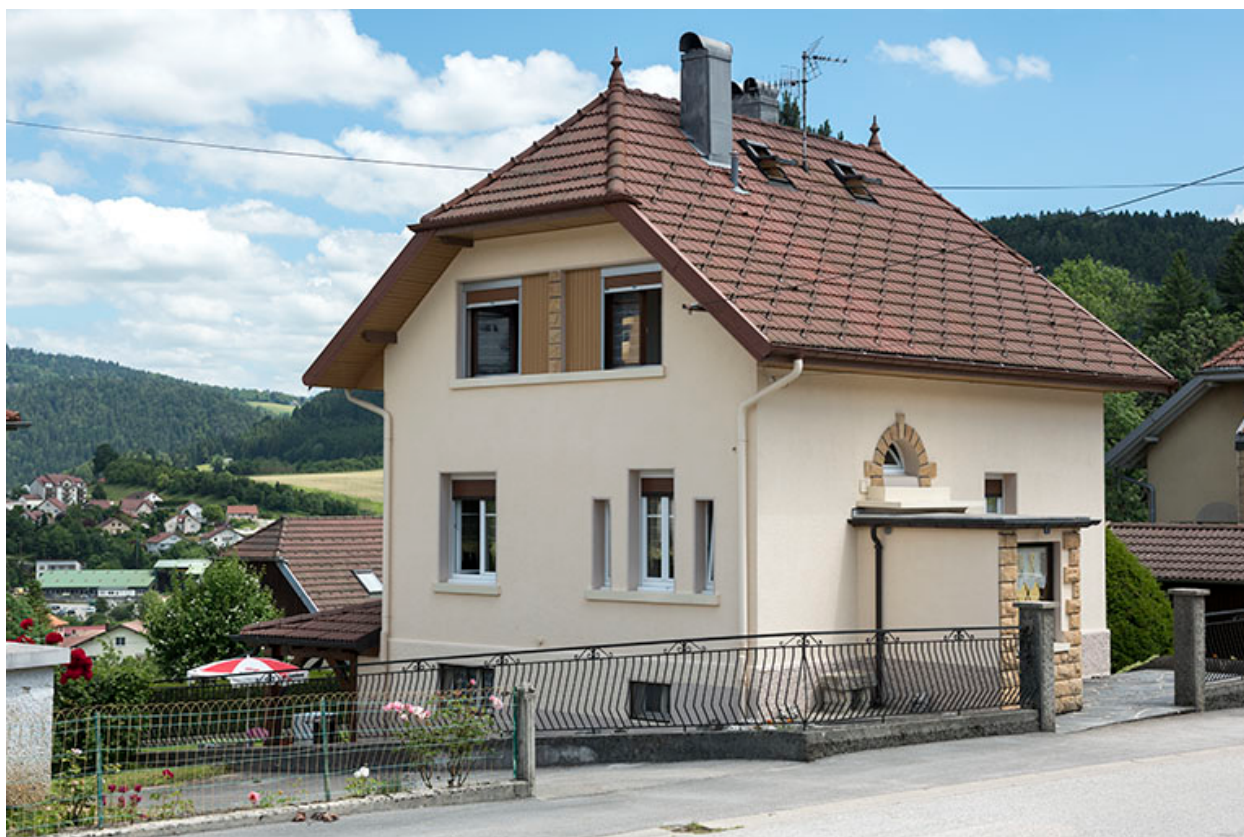
Façades antérieure et latérale gauche.
