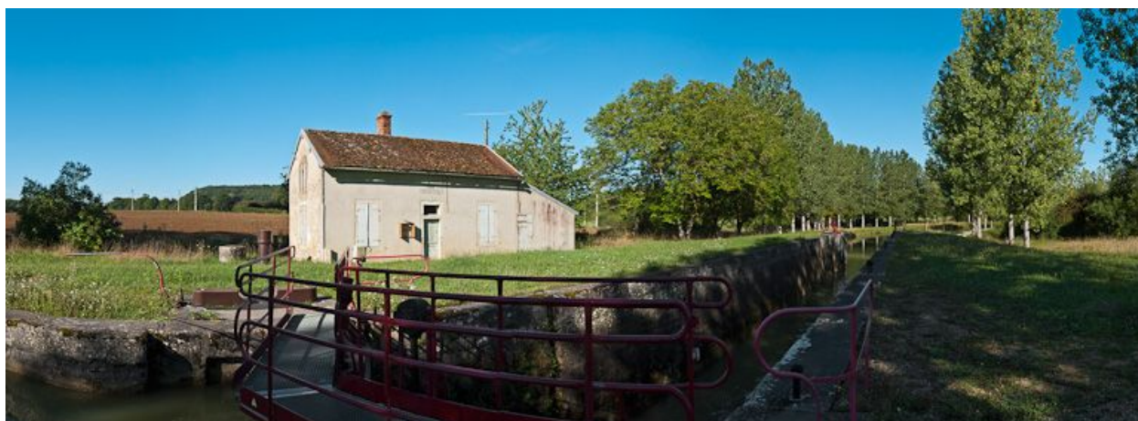
Vue d'ensemble du site d'écluse.
