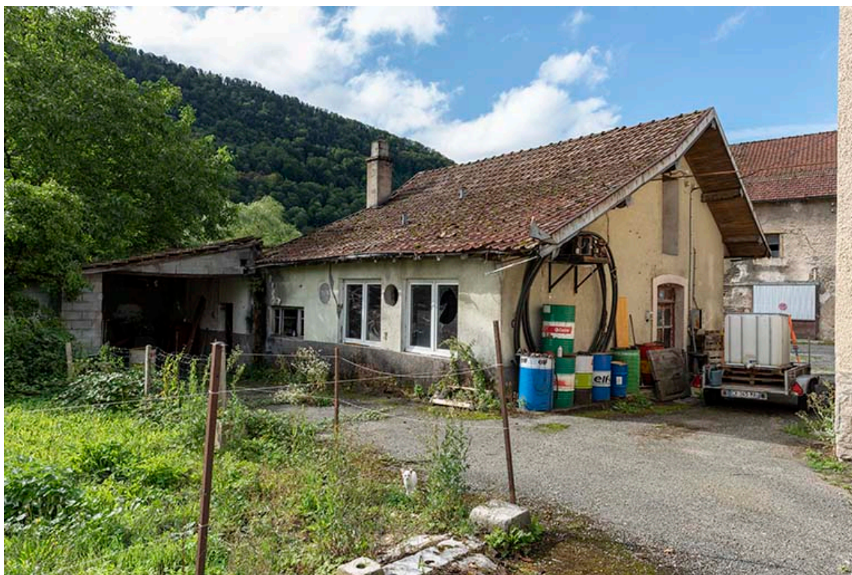
Façades antérieure et latérale gauche.
