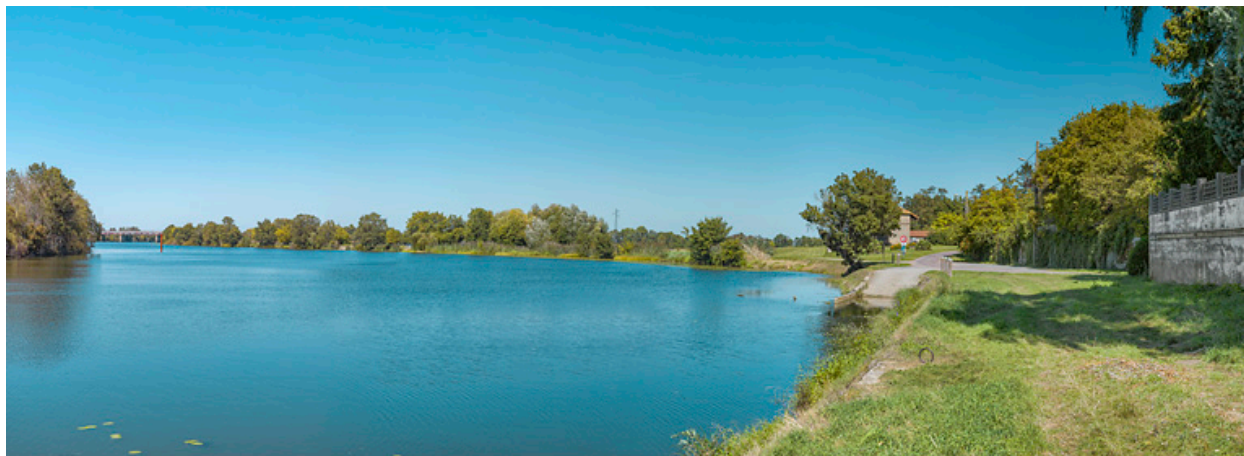
Vue d'ensemble des aménagements, depuis l'aval.
