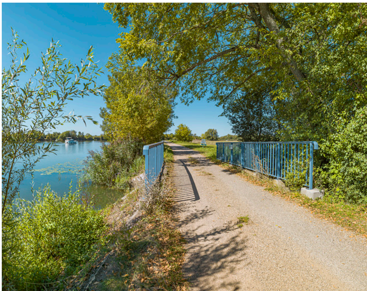
Vue d'ensemble du ponceau à la frontière entre Côte-d'Or et Saône-et-Loire.
