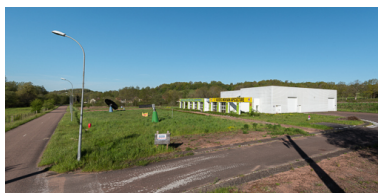
Vue d'ensemble du site. Phot. Pierre-Marie Barbe-Richaud IVR26_20192100053NUC4AQ
