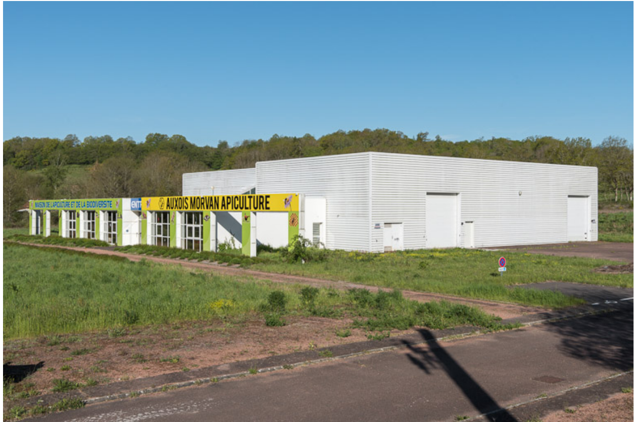
Vue de trois-quarts depuis le nord-est.
