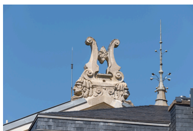
Lyre sur le pignon sud de la cage de scène.
