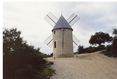
Vue d'ensemble en 2001. Phot. Jean-Luc Duthu IVR26_20012101002ZA
