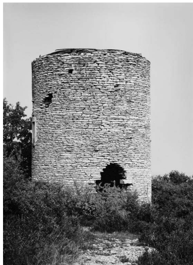
Vue d'ensemble en 1979. Phot. Michel Thierry IVR26_19792101489V
