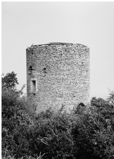
Vue d'ensemble en 1979. Phot. Michel Thierry IVR26_19792101488V
