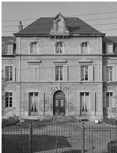
Façade antérieure, avant-corps central. Phot. Yves Sancey IVR43_19833900679X
