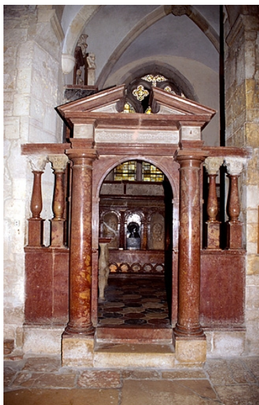
Vue d'ensemble. Phot. Yves Sancey IVR43_19977000033ZA
