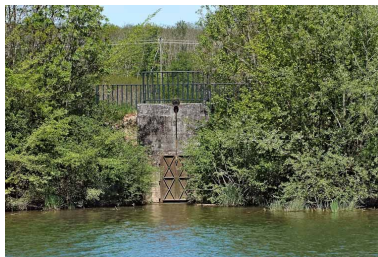
Vanne de l'aqueduc, Seille au premier plan. Phot. Jean-Luc Duthu IVR26_20107100522NUC2A
