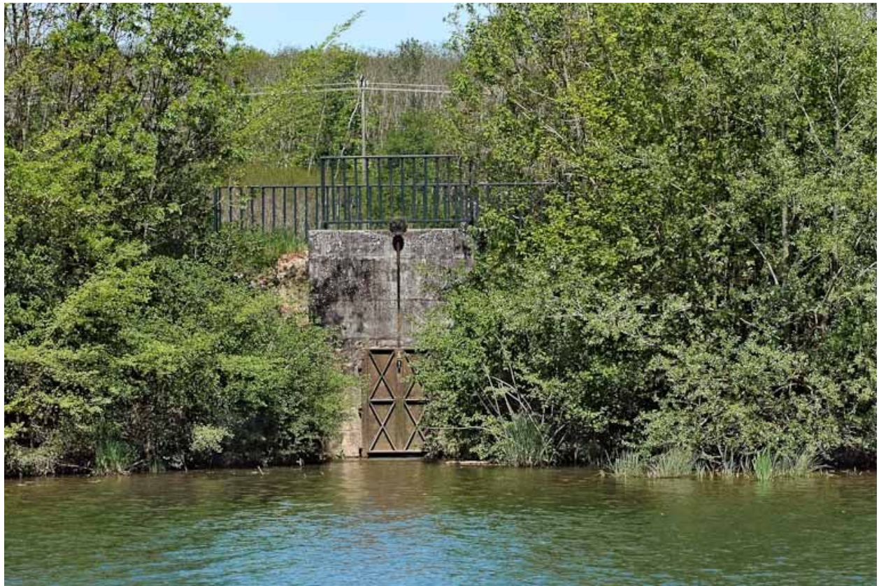
Vanne de l'aqueduc, Seille au premier plan.
