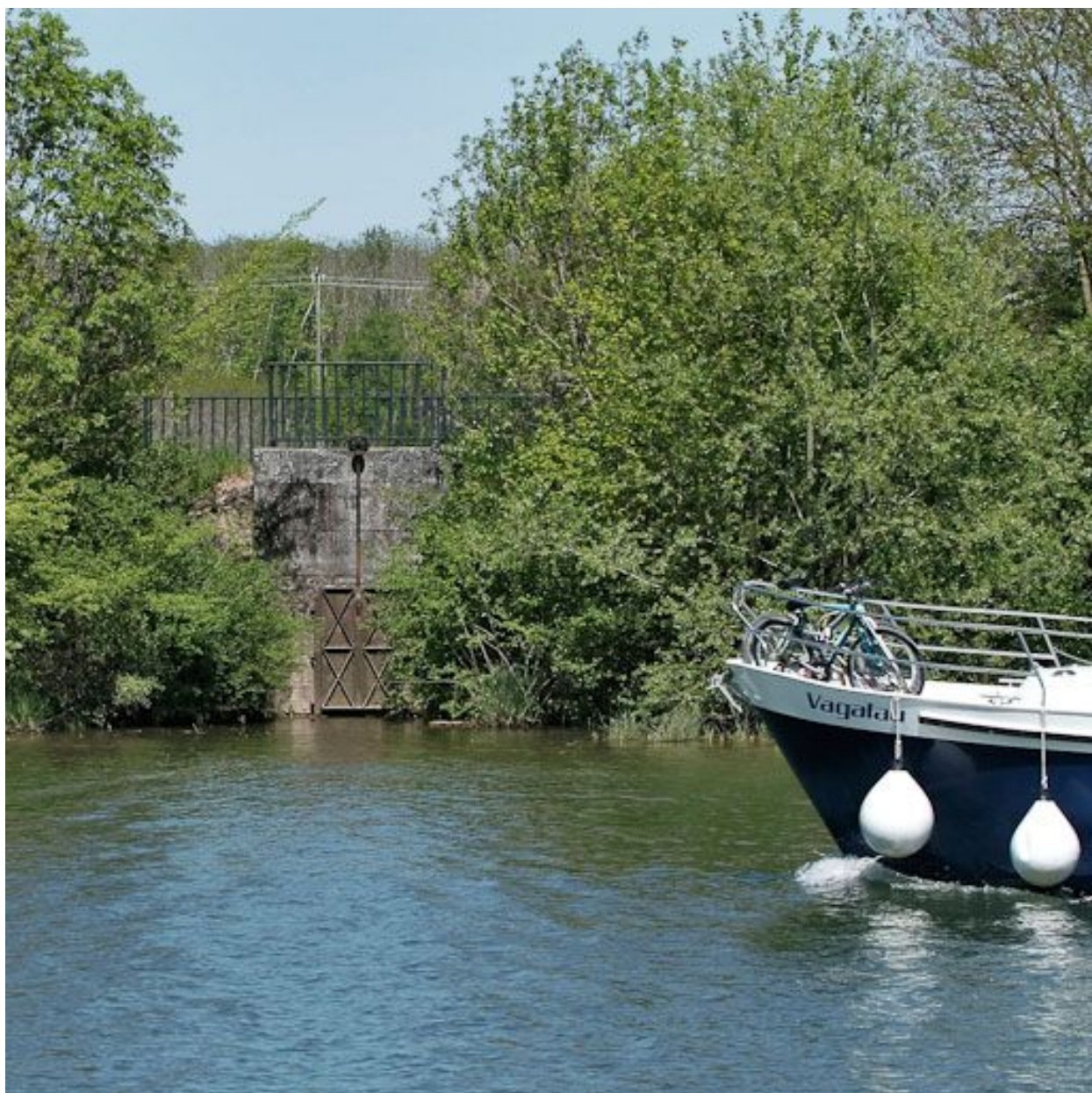
Vanne de l'aqueduc, Seille au premier plan.
