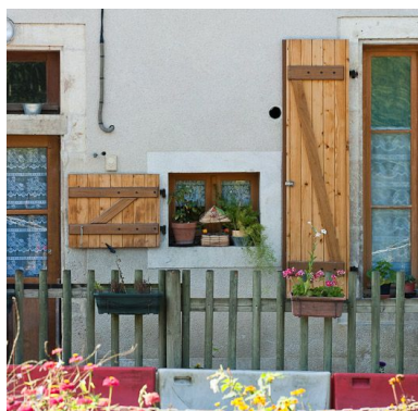
Détail des baies de la maison éclusière. Phot. Pierre-Marie Barbe-Richaud IVR26_20112104139NUC2AQ
