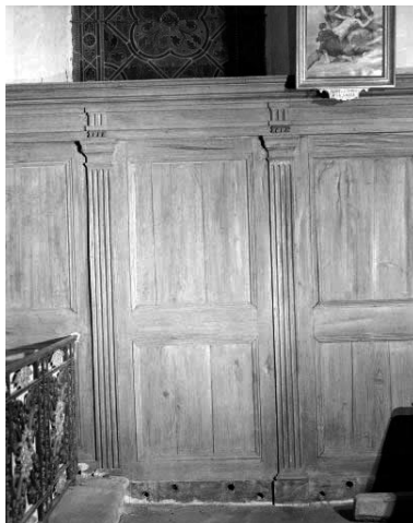
Détail : boiseries du chœur. Phot. Yves Sancey IVR43_19742500543X
