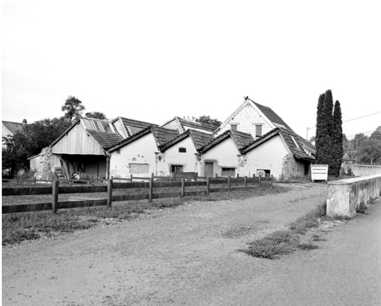
Extrémité orientale de l'atelier de fabrication.
