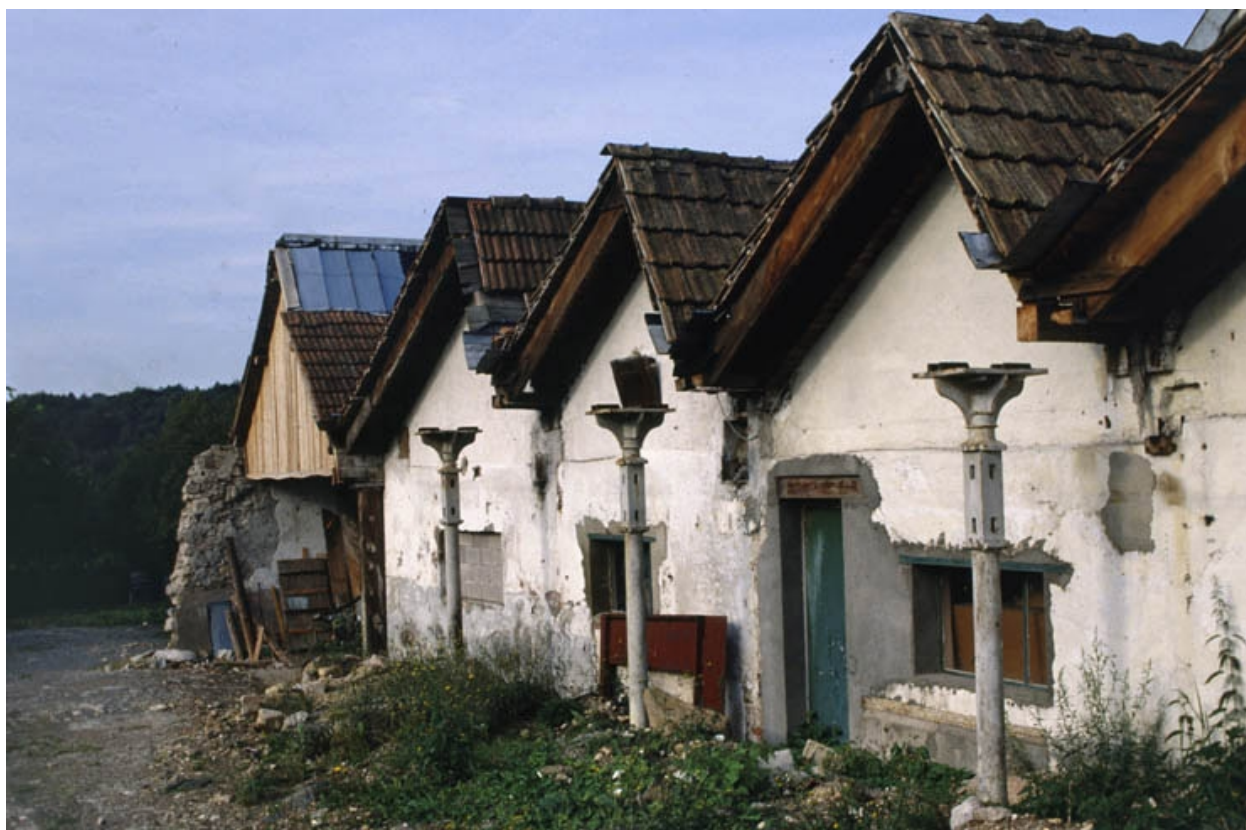
Sheds subsistants de l'atelier de fabrication.
