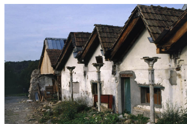
Sheds subsistants de l'atelier de fabrication. Phot. Yves Sancey IVR43_19999000197ZA
