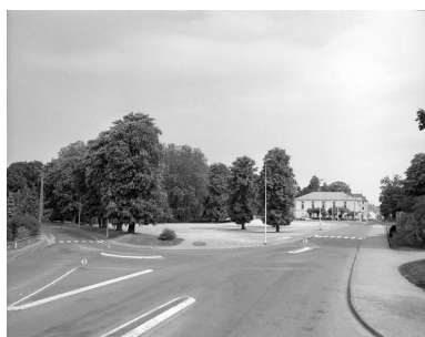
Vue d'ensemble éloignée. Phot. Yves Sancey IVR43_19927000221X
