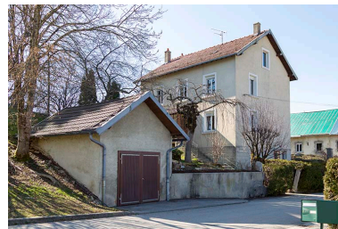
Vue d'ensemble, depuis le sud-ouest. Phot. Sonia Dourlot IVR43_20152500893NUC2A
