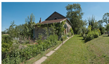
Vue du jardin du site d'écluse. Phot. Pierre-Marie Barbe-Richaud IVR26_20112103711NUC4AQ
