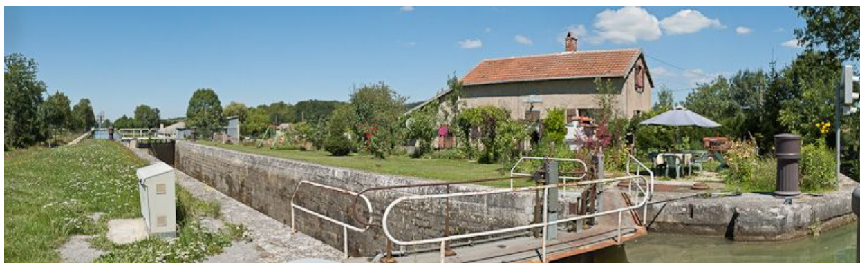
Vue d'ensemble du site d'écluse.
