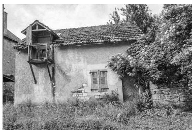
Maison cadastrée 1979 AB 10 : façade antérieure. Phot. Bernard Lardière IVR43_19817000268Z
