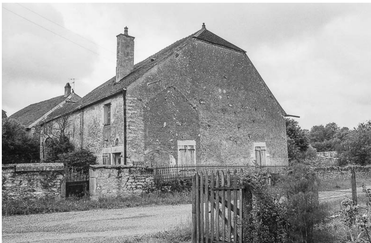
Ferme 4 : bâtiment d'habitation.
