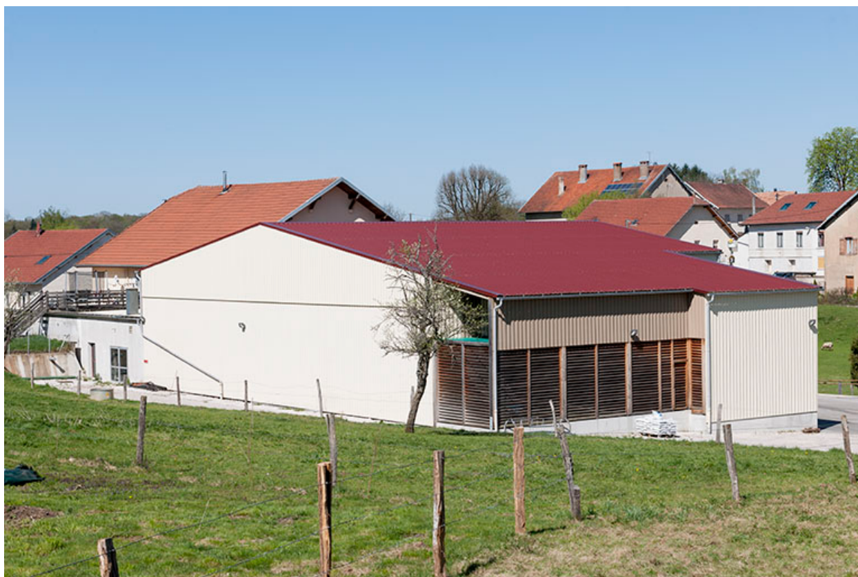
Extension des caves d'affinage.
