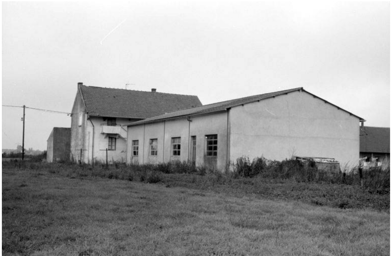
Nouvelle fromagerie, vue de l'est.
