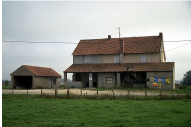
Ancienne fromagerie et remise, vues de l'ouest. Phot. Laurent Poupard IVR43_19883900694ZA
