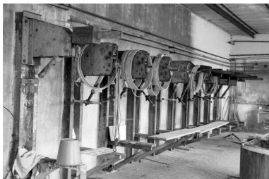
Atelier de fabrication : les presses. Phot. Laurent Poupard IVR43_19883900697Z
