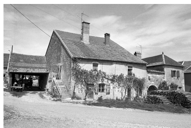
Ferme située rue Tortueuse. Phot. Bernard Lardière IVR43_19817000346Z
