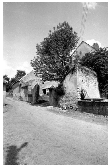
Ferme située impasse des Tilleuls. Phot. Bernard Lardière IVR43_19817000334Z
