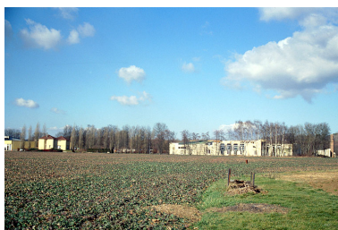
Local du comité d'entreprise : vue d'ensemble depuis l'est. Phot. Laurent Poupard IVR43_19903900236ZA
