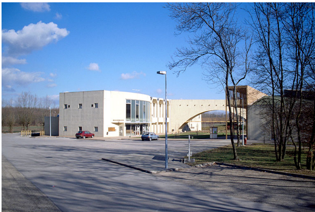
Local du comité d'entreprise : groupement d'achats et cour intérieure, vus du sud-ouest.
