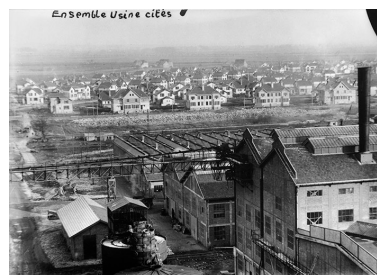
Vue d'ensemble : générateurs de vapeur et d'électricité et ateliers de réparation de l'usine en avant de la cité ouvrière de Tavaux.
