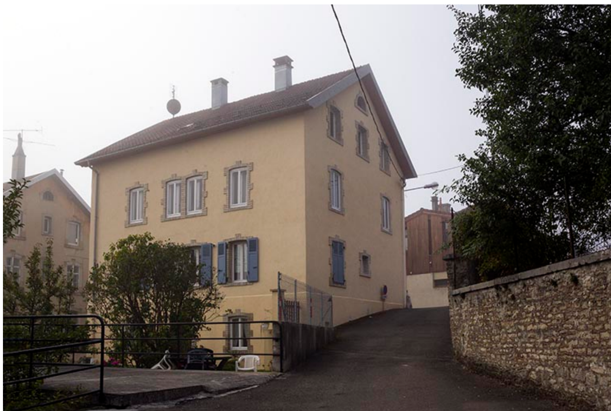
Façades postérieure et latérale gauche.
