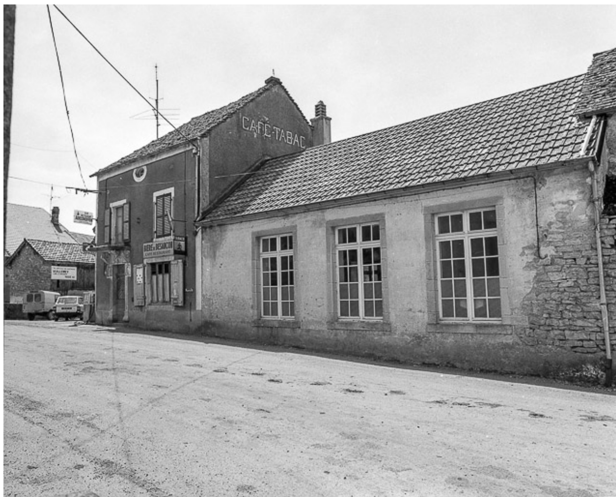
Ecole située route de Mirebel : façade antérieure.
