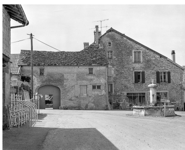
Ferme située place de l'Eglise. Phot. Yves Sancey IVR43_19813900170X
