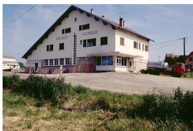
Fromagerie située route de Chaumois. Phot. Jérôme Mongreville IVR43_19953900210ZA
