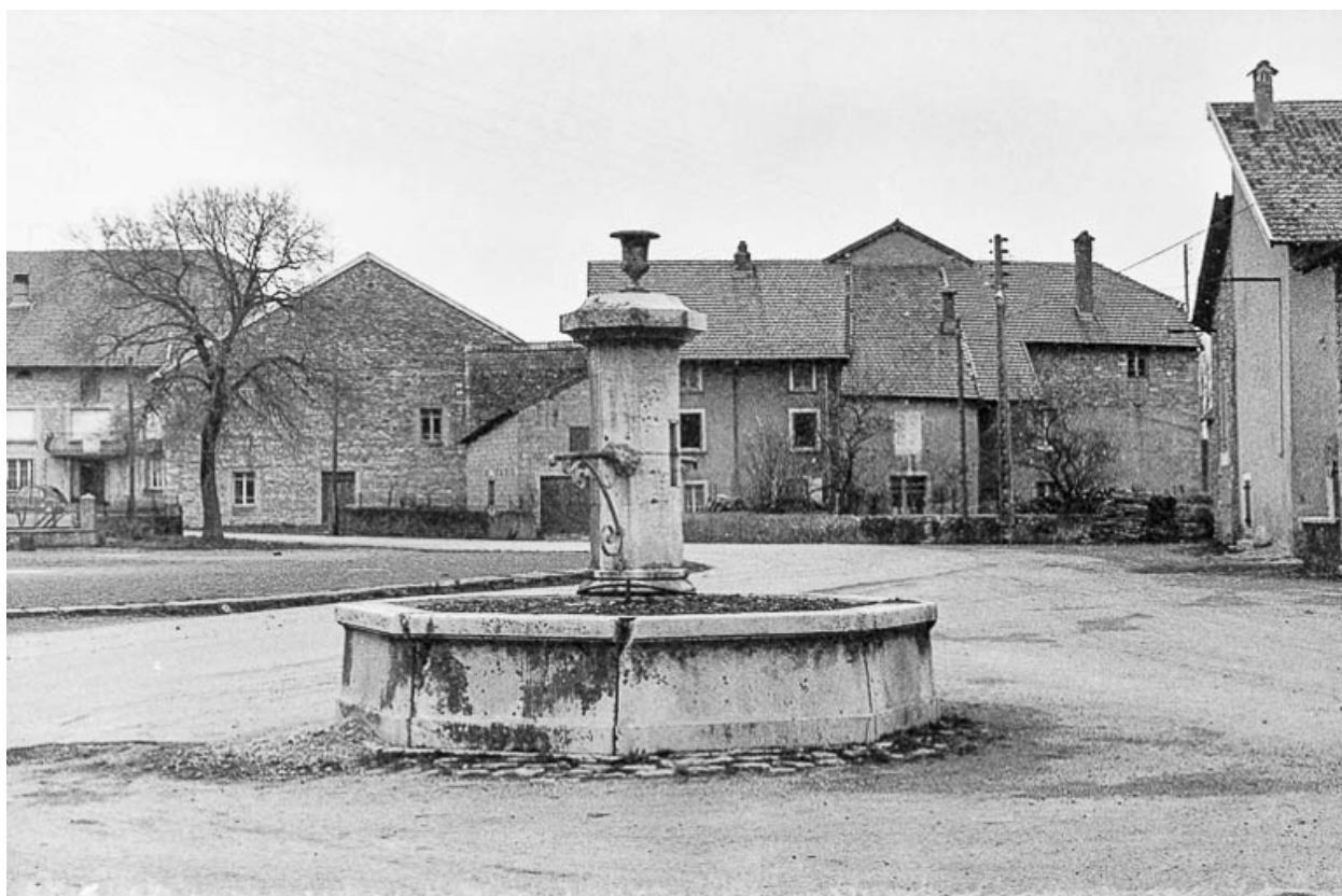
Fontaine en calcaire, XIXe siècle : vue d'ensemble
