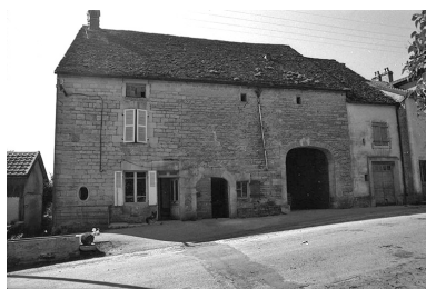
Ferme située rue Haute. Phot. F. Pernin IVR43_19743900216Z
