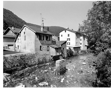
Vue d'ensemble, depuis le sud- est : élévations postérieures. Phot. Yves Sancey IVR43_20033900347X
