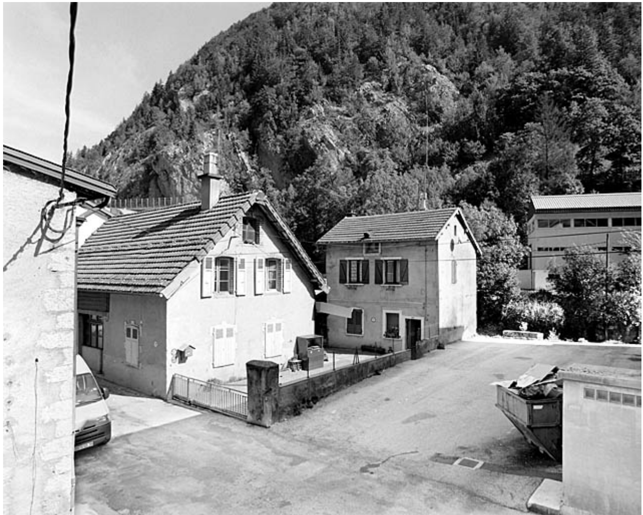
Vue d'ensemble, depuis le sud-ouest : élévations antérieures.
