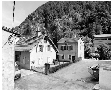
Vue d'ensemble, depuis le sud- ouest : élévations antérieures. Phot. Yves Sancey IVR43_20033900344X
