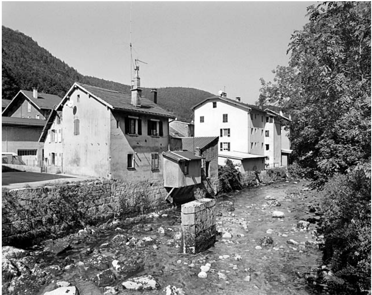
Vue d'ensemble, depuis le sud-est : élévations postérieures.
