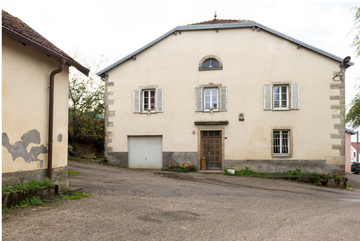
Vue de face : pignon est.
