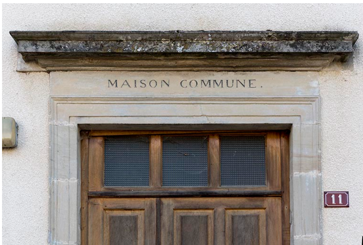
Pignon est : détail du linteau de l'entrée.
