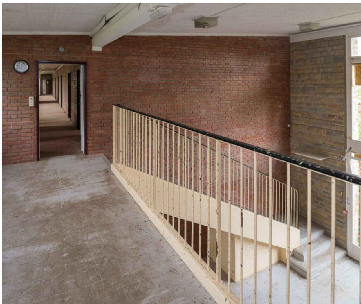
Salle de jeux au centre de l'aile Bellevue, escalier, palier supérieur.
