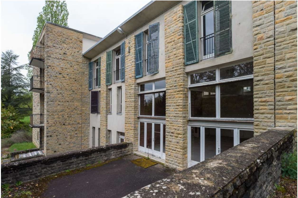
Élévation extérieure de l'aile Régina, côté sud, jonction avec le corps de bâtiment principal.
