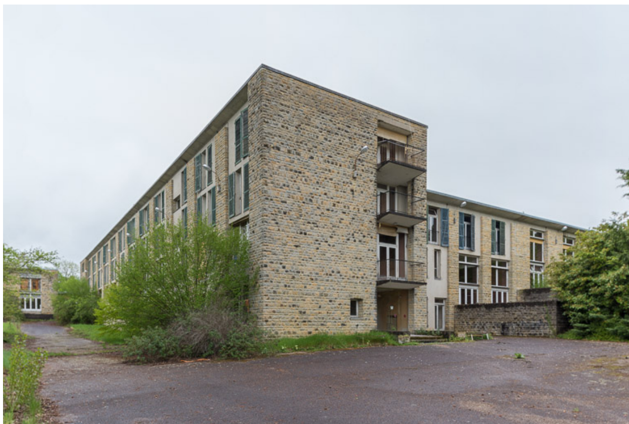
Élévation extérieure du corps de bâtiment principal.
