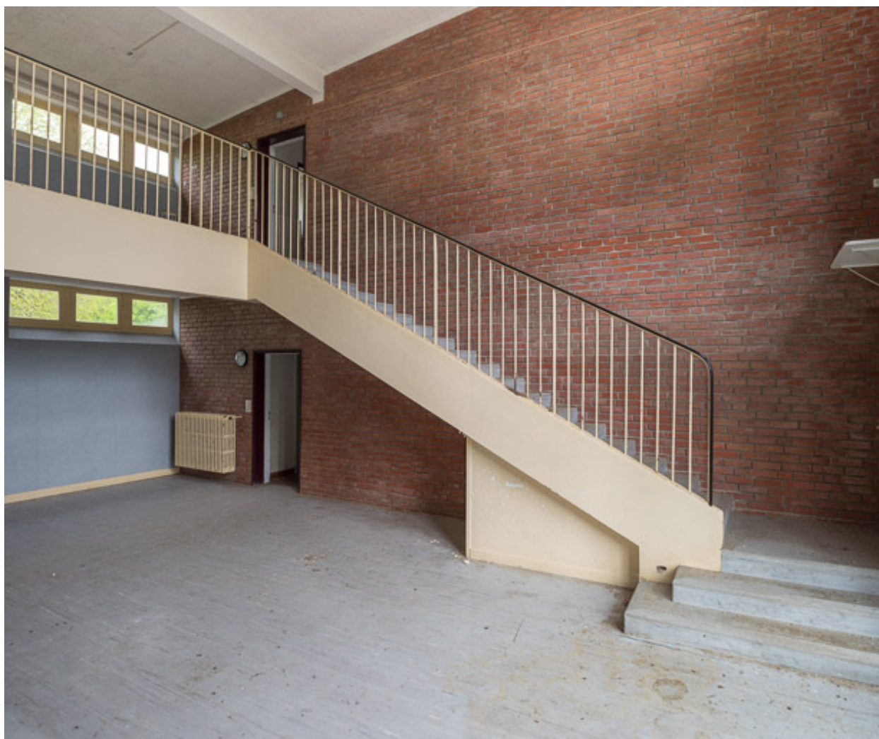
Salle de jeux au centre de l'aile Bellevue, escalier, palier inférieur.
