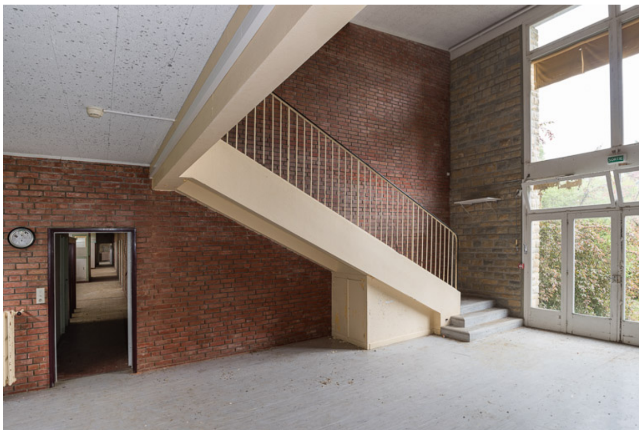
Salle de jeux au centre de l'aile Bellevue, escalier, palier inférieur.
