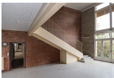
Salle de jeux au centre de l'aile Bellevue, escalier, palier inférieur. Phot. Pierre-Marie Barbe-Richaud IVR26_20195800084NUC4AQ
