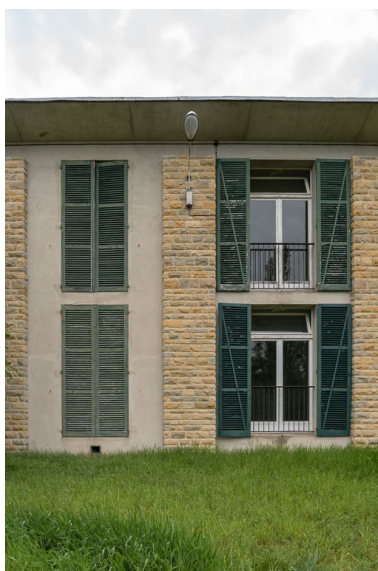
Élévation extérieure de l'aile Bellevue, côté sud, détail de deux travées. Phot. Pierre-Marie Barbe-Richaud IVR26_20195800089NUC4A
