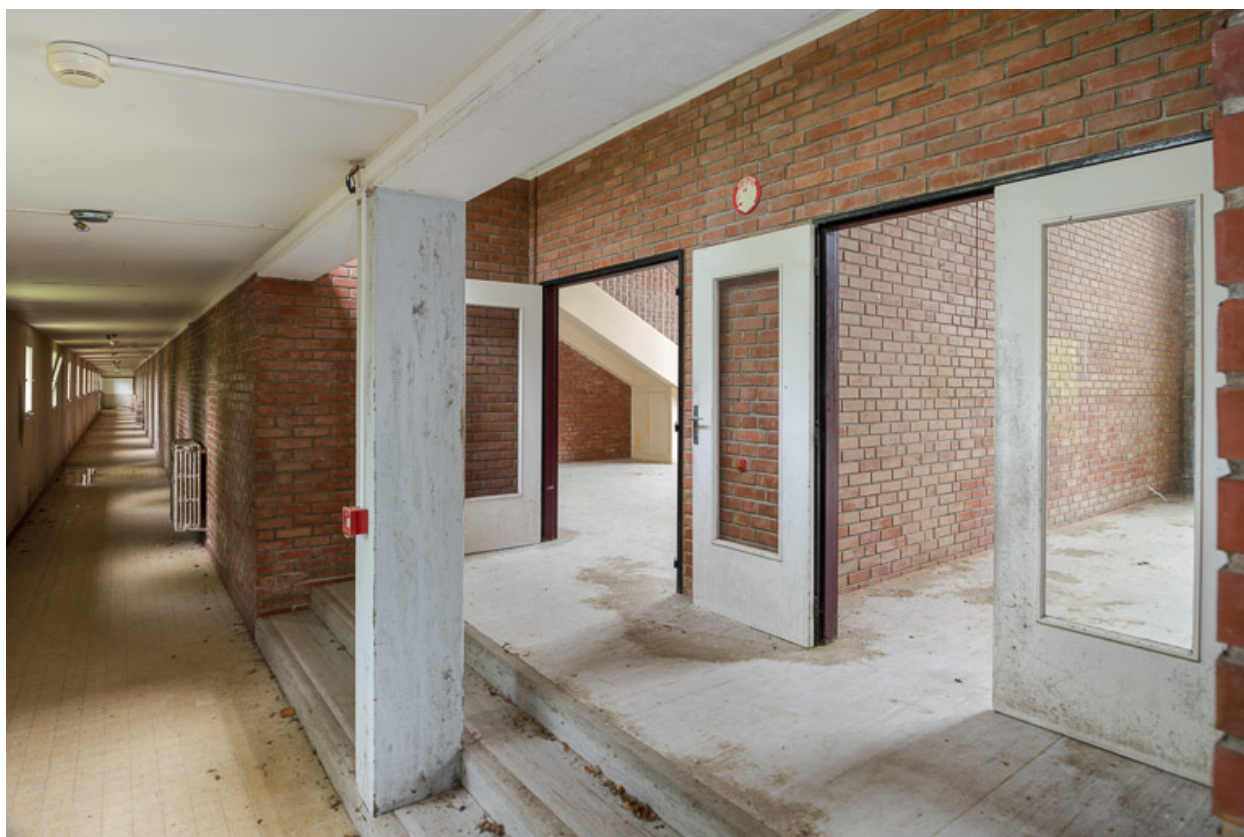
Couloir nord de l'aile Bellevue, vue en direction de l'est, et accès aux salles de jeux.
