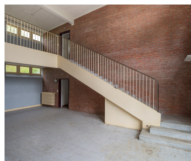
Salle de jeux au centre de l'aile Bellevue, escalier, palier inférieur. Phot. Pierre-Marie Barbe-Richaud IVR26_20195800083NUC4AQ
