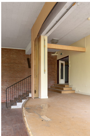
Salle de spectacle dans le corps de bâtiment principal. Phot. Pierre-Marie Barbe-Richaud IVR26_20195800093NUC4A
