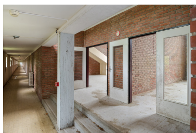
Couloir nord de l'aile Bellevue, vue en direction de l'est, et accès aux salles de jeux. Phot. Pierre-Marie Barbe-Richaud IVR26_20195800085NUC4AQ
