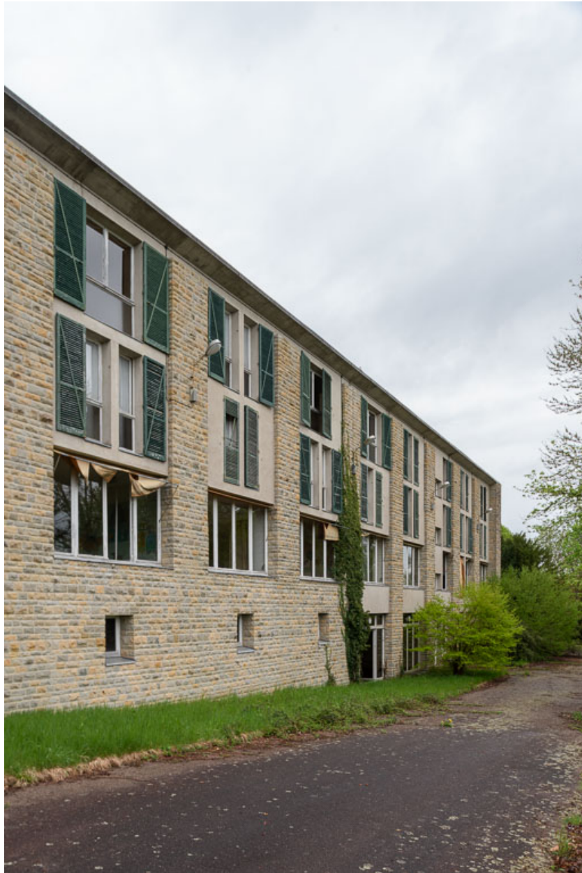
Élévation extérieure du corps de bâtiment principal.
