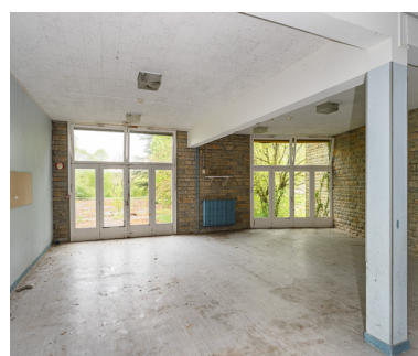
Salle de jeux à l'extrémité ouest de l'aile Bellevue. Phot. Pierre-Marie Barbe-Richaud IVR26_20195800088NUC2AQ
