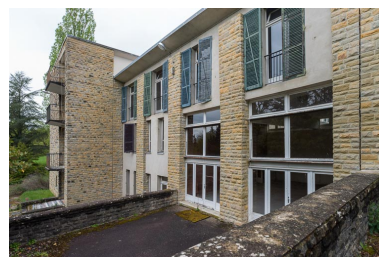
Élévation extérieure de l'aile Régina, côté sud, jonction avec le corps de bâtiment principal. Phot. Pierre-Marie Barbe-Richaud IVR26_20195800095NUC4AQ
