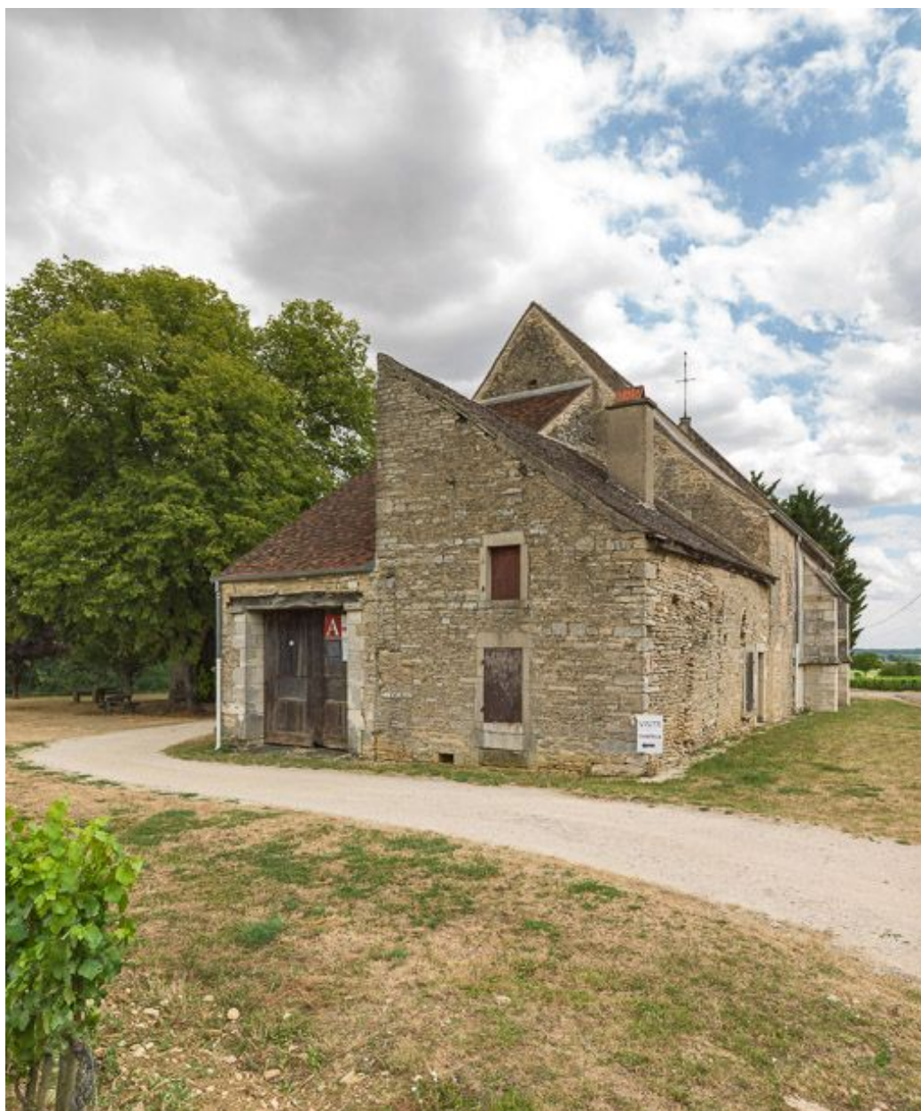
Vue de la façade ouest.
