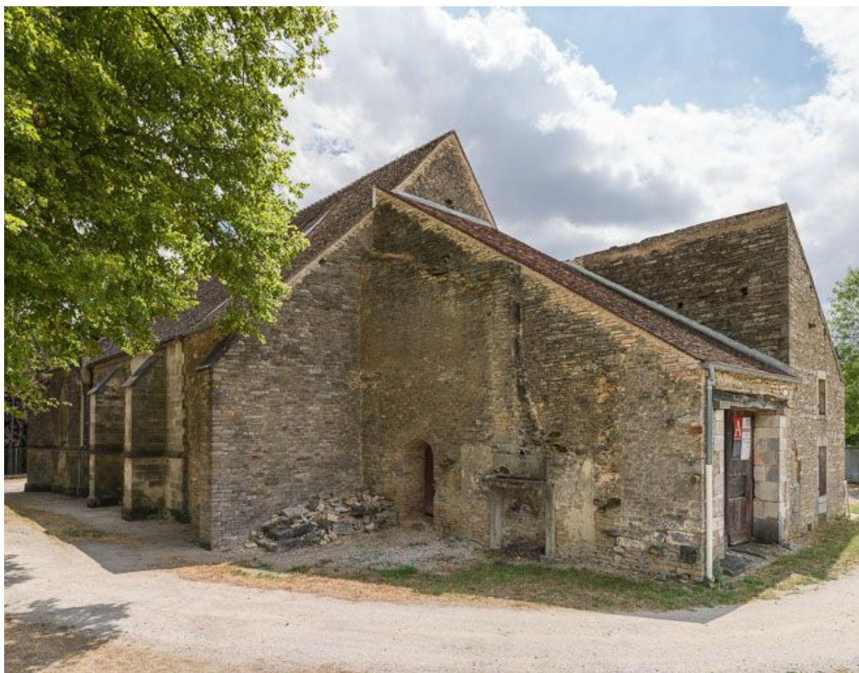
Vue de l'angle nord-ouest.
