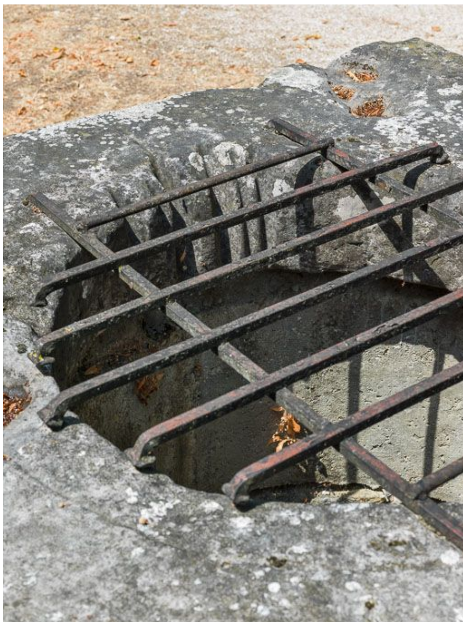
Puits : grille et traces d'usure de cordes.
