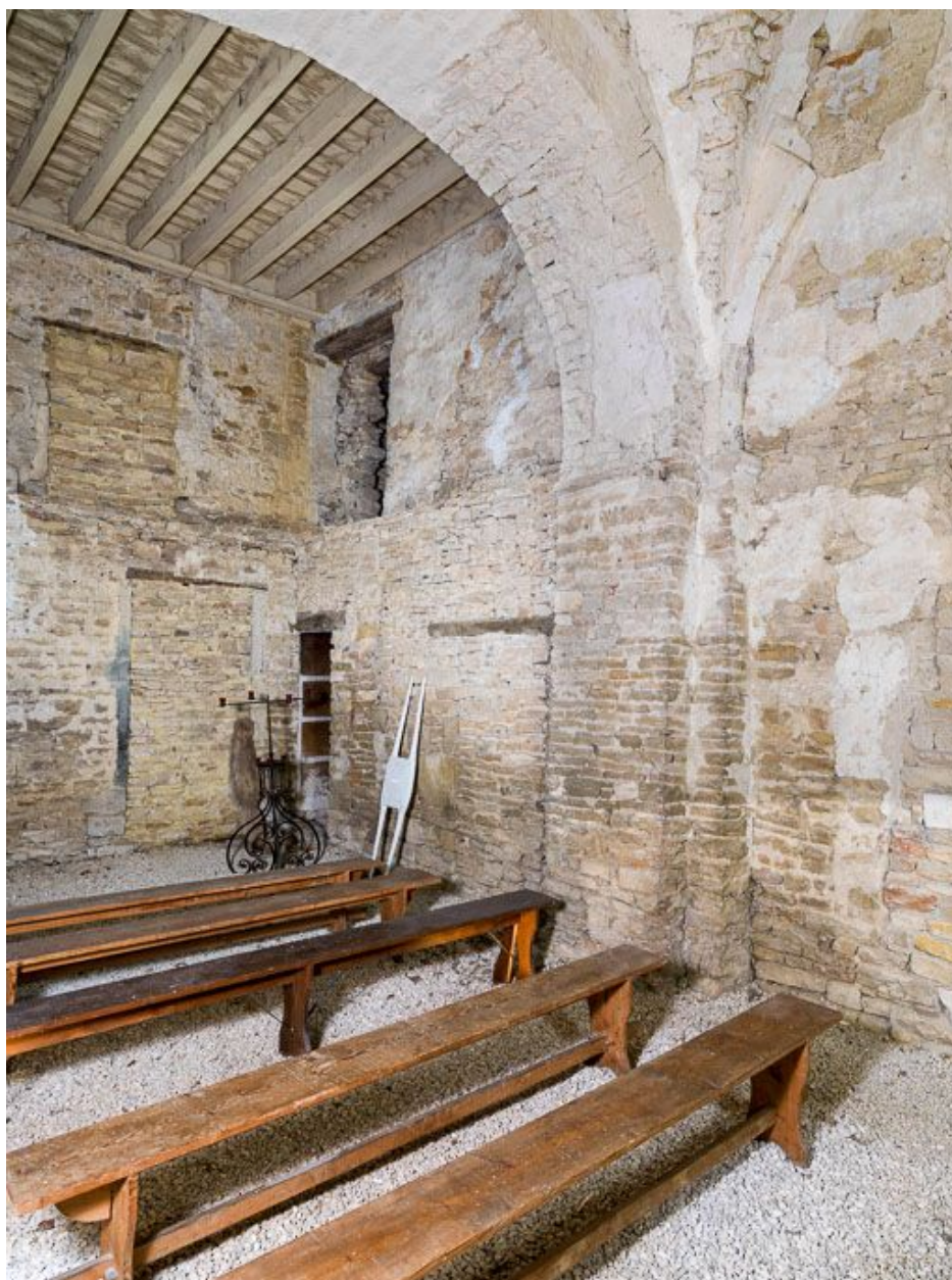
Ancienne chapelle : vue de l'angle sud-ouest.
