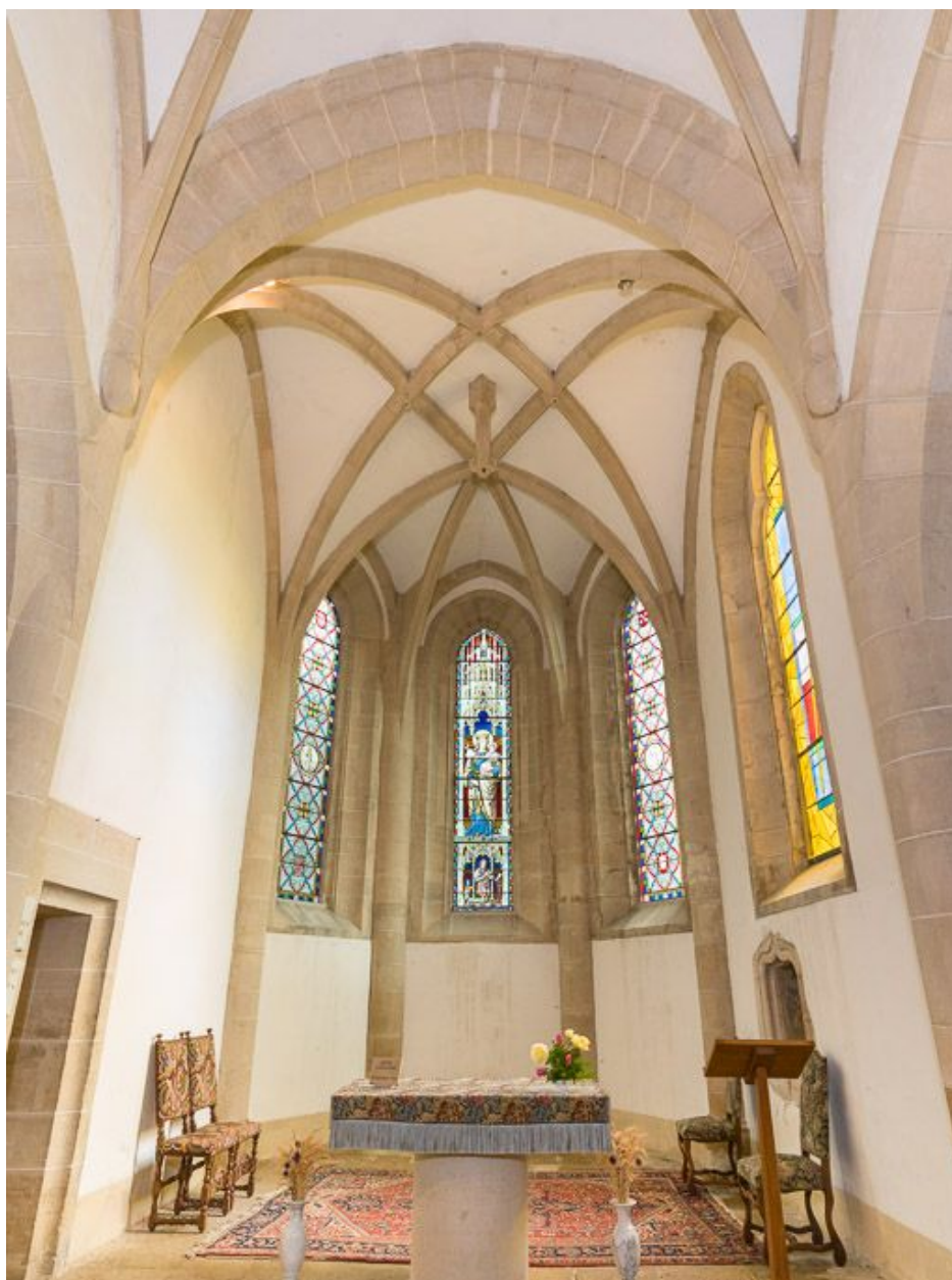
Vue de la voûte du chœur.
