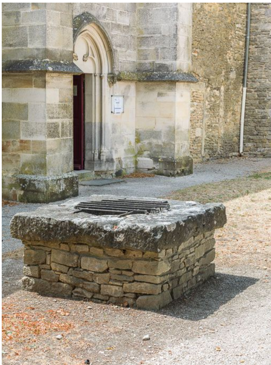
Puits : vue d'ensemble.
