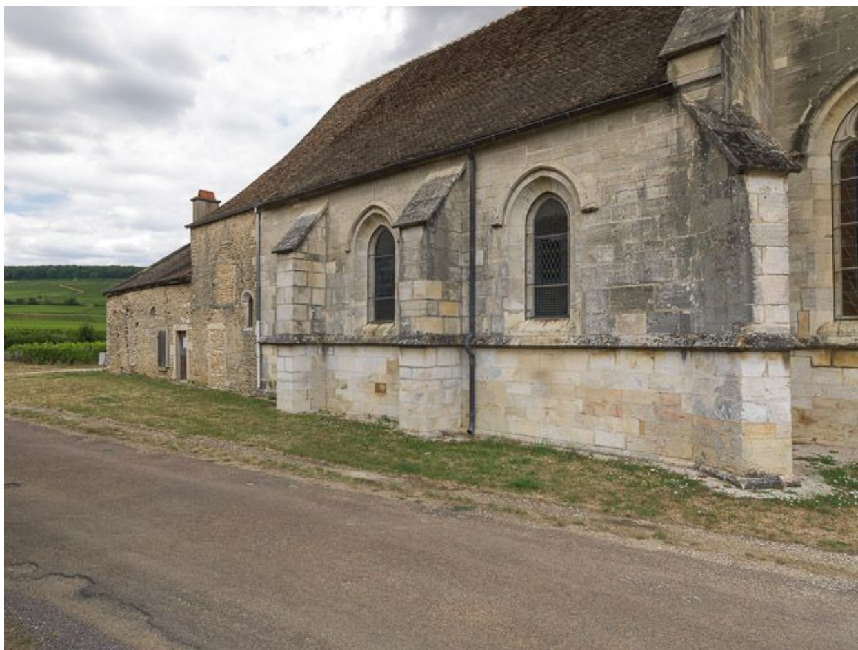
Vue du pignon sud de la chapelle.
