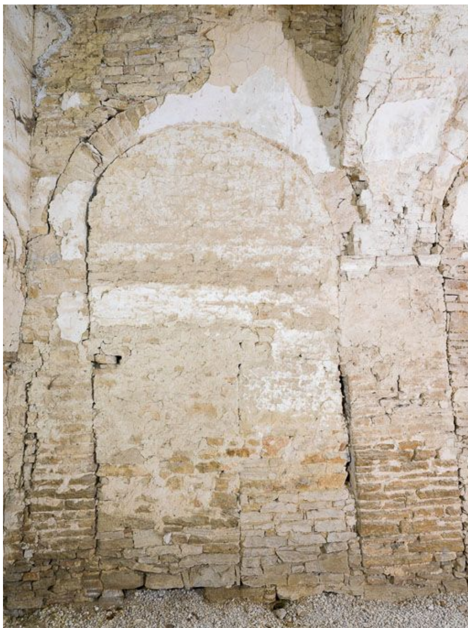
Ancienne chapelle : vue du mur est.
