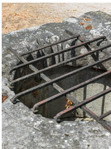
Puits : grille et traces d'usure de cordes. Phot. Pierre-Marie Barbe-Richaud IVR26_20152101439NUC4A
