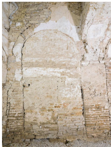
Ancienne chapelle : vue du mur est. Phot. Pierre-Marie Barbe-Richaud IVR26_20152100606NUC4A
