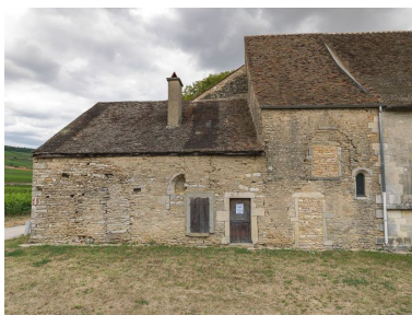
Vue du pignon sud. Phot. Pierre-Marie Barbe-Richaud IVR26_20152101431NUC4A
