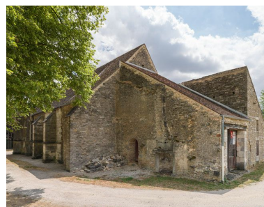
Vue de l'angle nord-ouest. Phot. Pierre-Marie Barbe-Richaud IVR26_20152101434NUC4A
