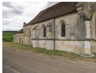
Vue du pignon sud de la chapelle. Phot. Pierre-Marie Barbe-Richaud IVR26_20152101432NUC4A
