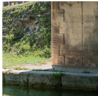
Détail des marques de halage sur la pile du pont. Phot. Pierre-Marie Barbe-Richaud IVR26_20128900398NUC2AQ
