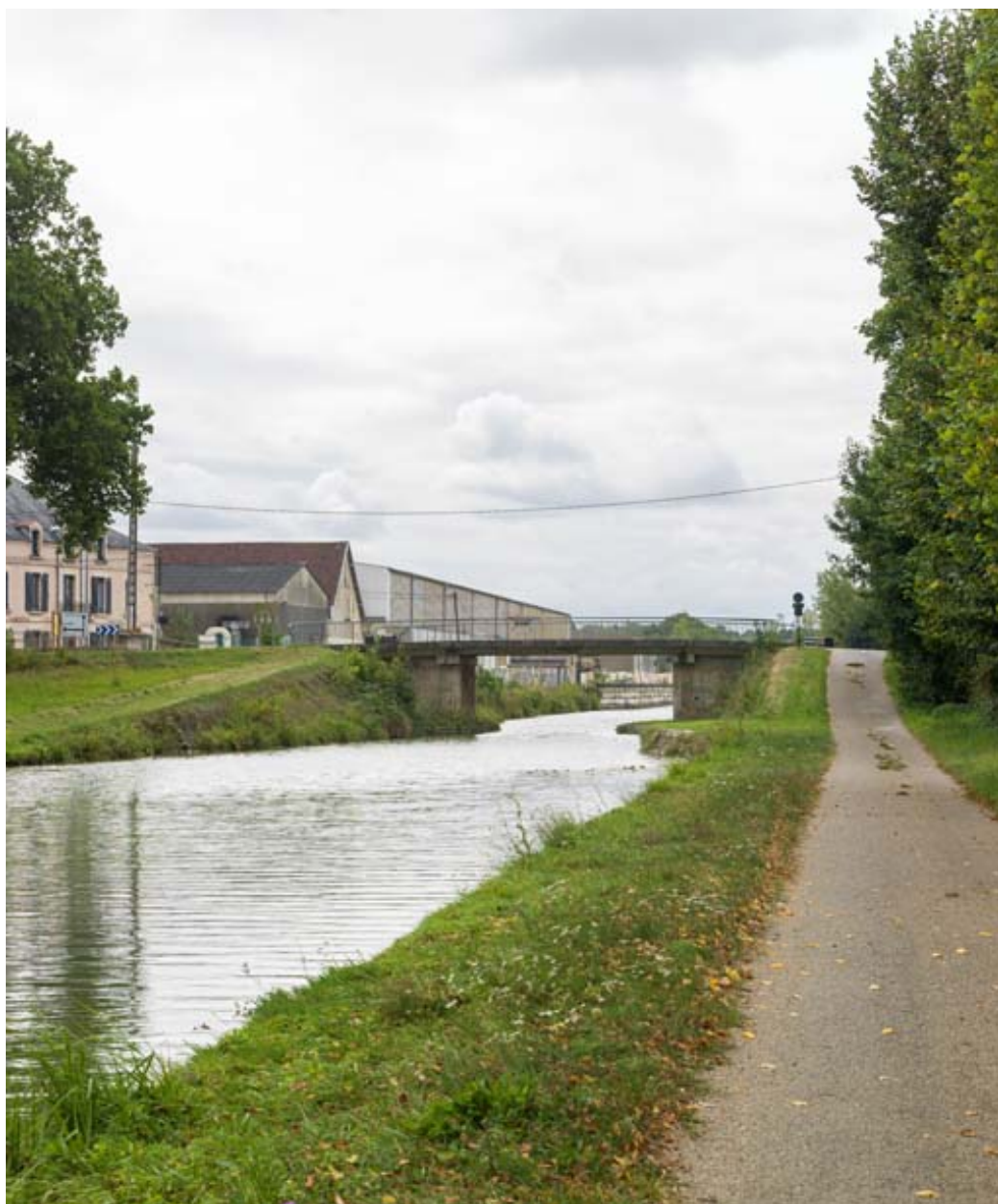
Vue d'ensemble du pont.
