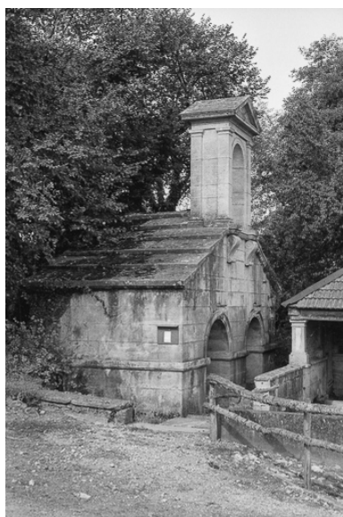
Détail : la fontaine. Phot. Bernard Lardière IVR43_19797000256Z
