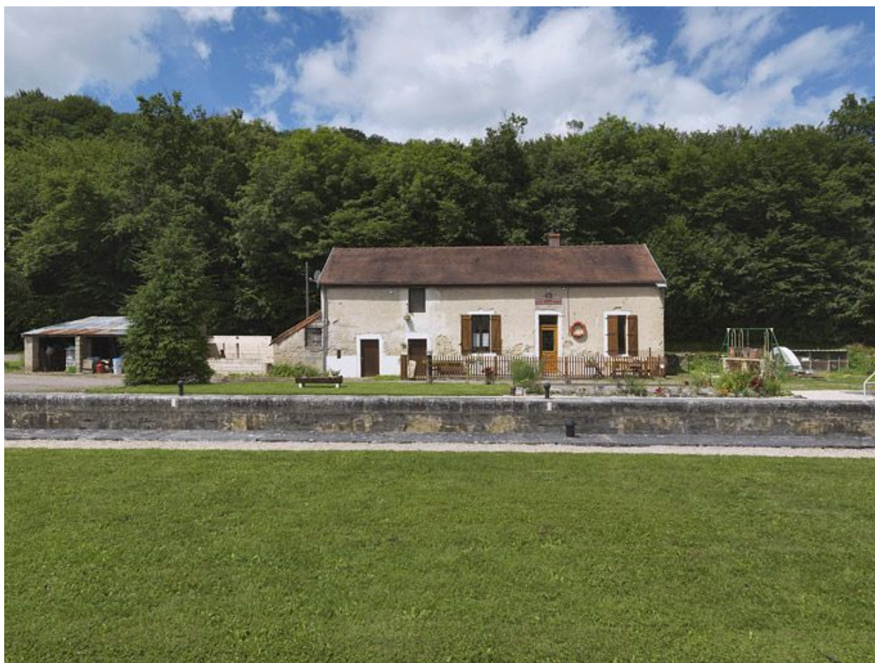
Maison éclusière vue de face.
